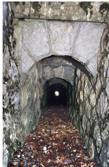
Voûte appareillée en rouleaux à ressauts, vue depuis l'amont (nord). Phot. Yves Sancey IVR43_20053900566ZA
