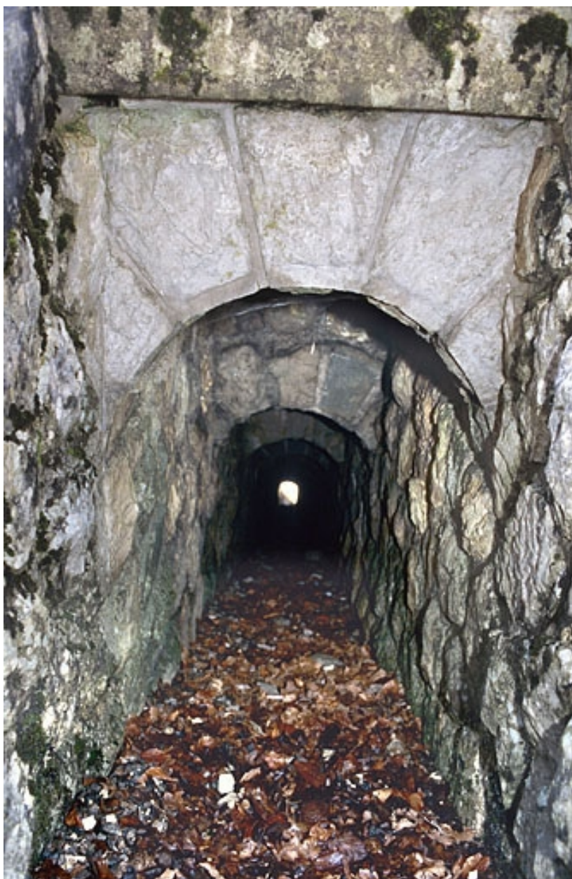
Voûte appareillée en rouleaux à ressauts, vue depuis l'amont (nord).
