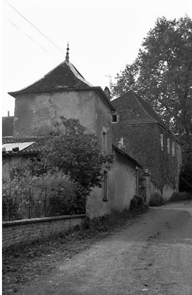
Façades sur rue. Phot. Bernard Lardière IVR43_19797000252Z
