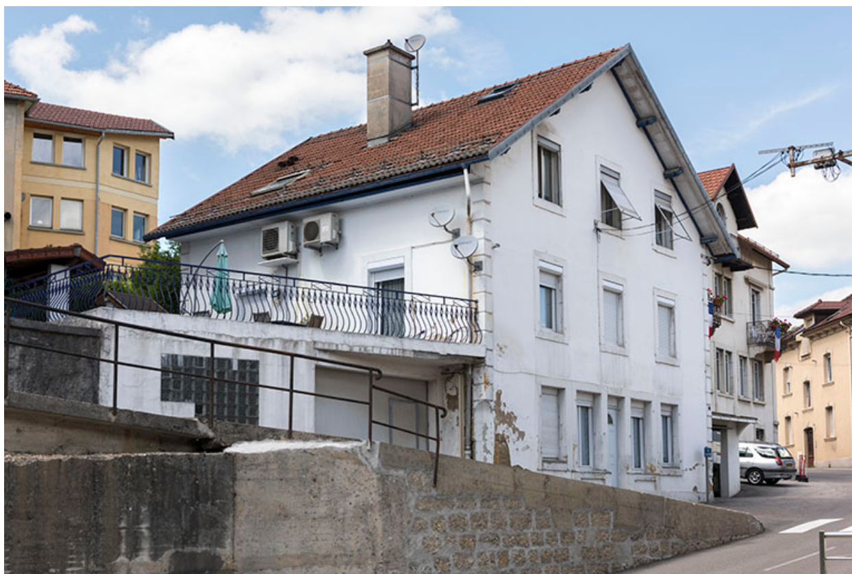
Façades antérieure et latérale gauche.
