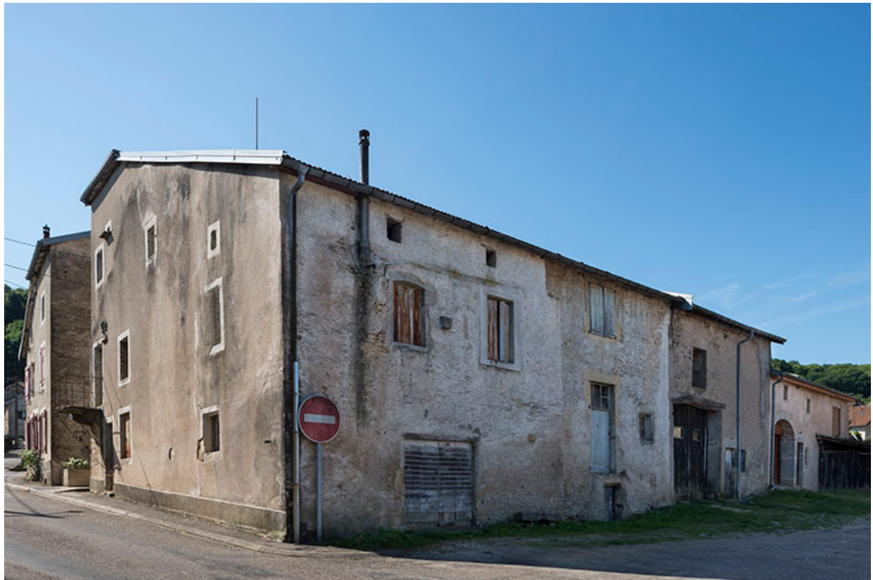
Vue depuis le nord.
