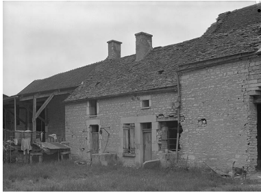
Maison et puits adossé à la façade.
