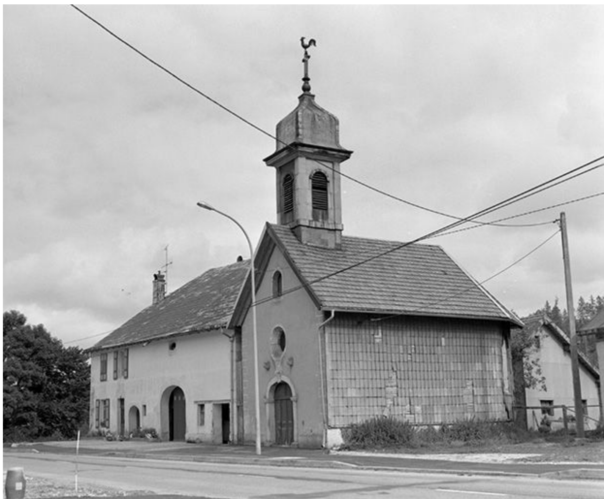
Façades antérieure et latérale droite.
