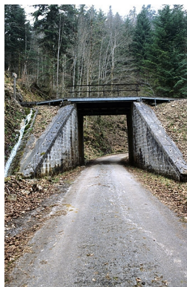
Pont, depuis la route côté vallée. Phot. Yves Sancey IVR43_20053900154ZA
