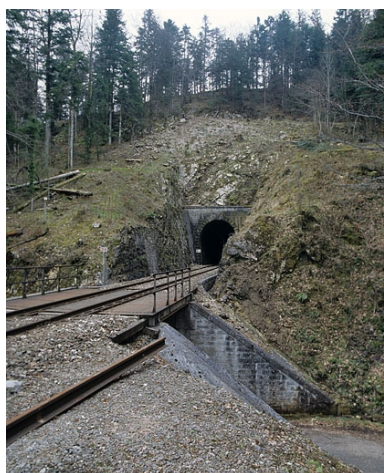
Pont et tunnel, côté Andelot-en-Montagne. Phot. Yves Sancey IVR43_20053900151XA
