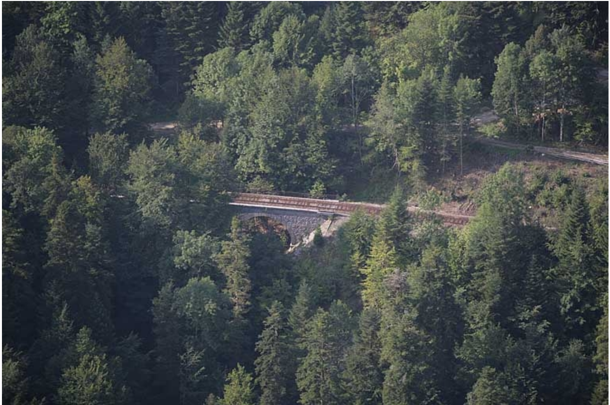
Vue aérienne du viaduc, depuis le nord.
