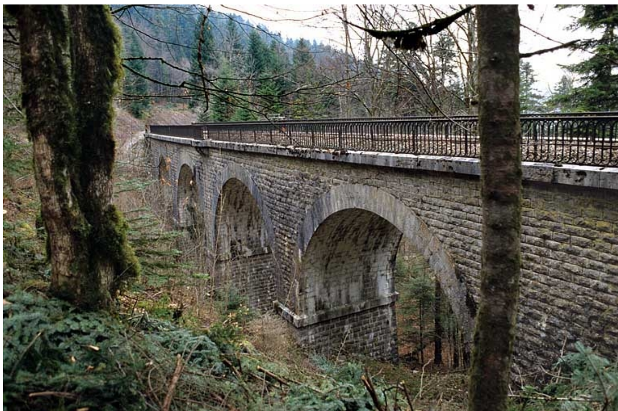
Viaduc : élévation sud (côté rocher).
