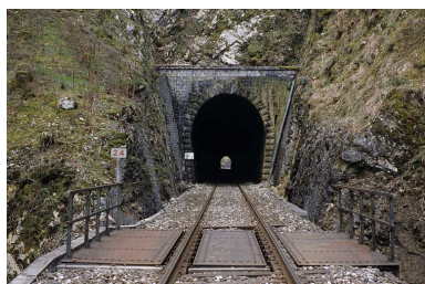
Tunnel : tête côté Andelot-en-Montagne. Phot. Yves Sancey IVR43_20053900160ZA
