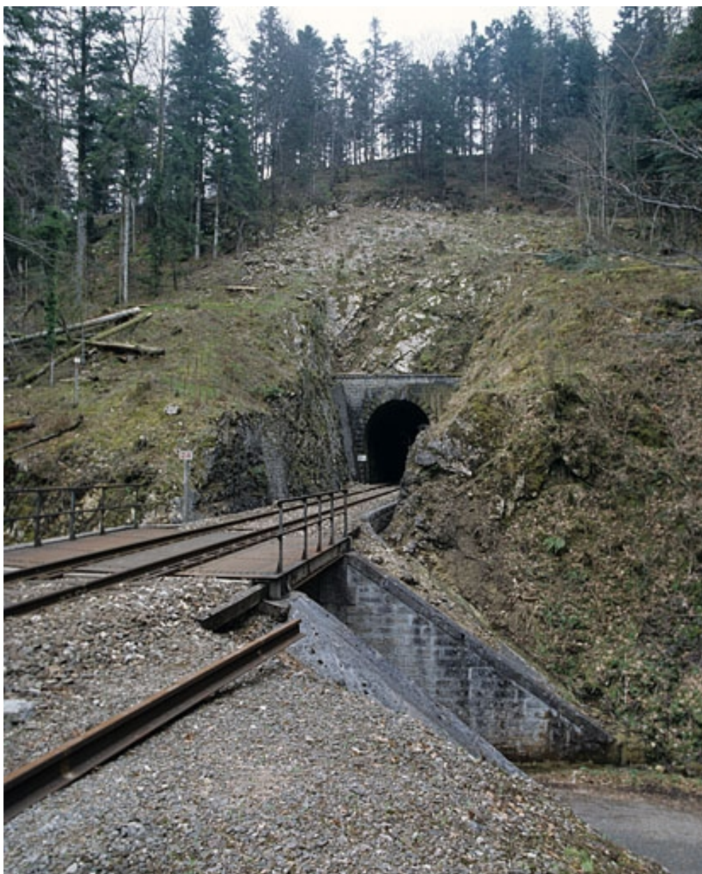
Pont et tunnel, côté Andelot-en-Montagne.
