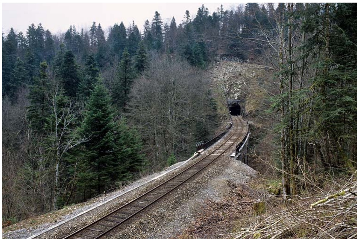
Vue d'ensemble, depuis le nord-ouest (côté Andelot-en-Montagne).
