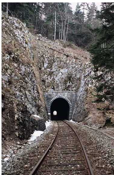
Tunnel : tête côté La Cluse. Phot. Yves Sancey IVR43_20053900161ZA
