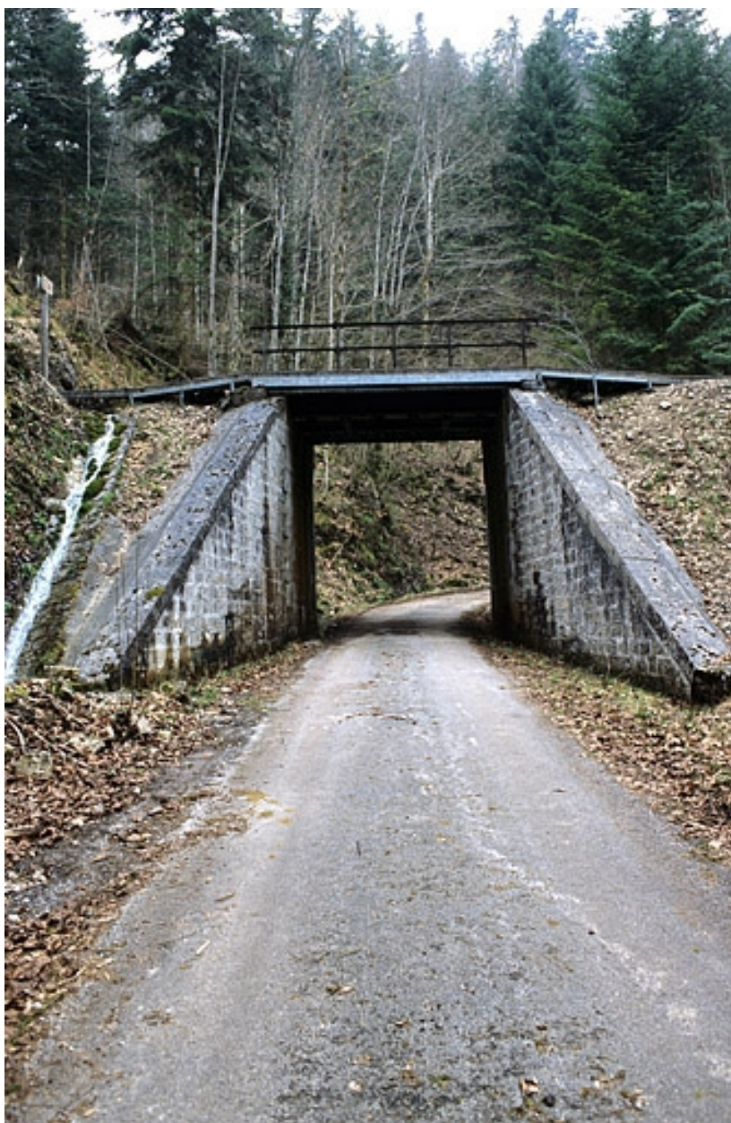
Pont, depuis la route côté vallée.
