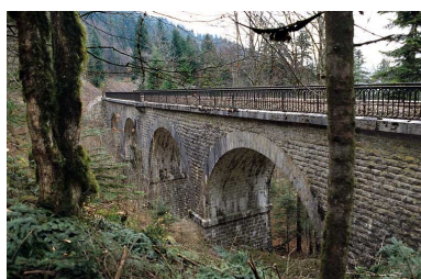
Viaduc : élévation sud (côté rocher).
