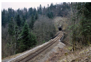
Vue d'ensemble, depuis le nord-ouest (côté Andelot-en-Montagne).
