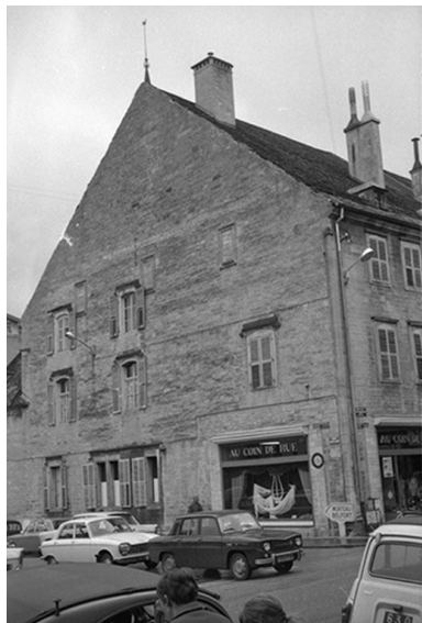
Façade latérale gauche en 1968.
