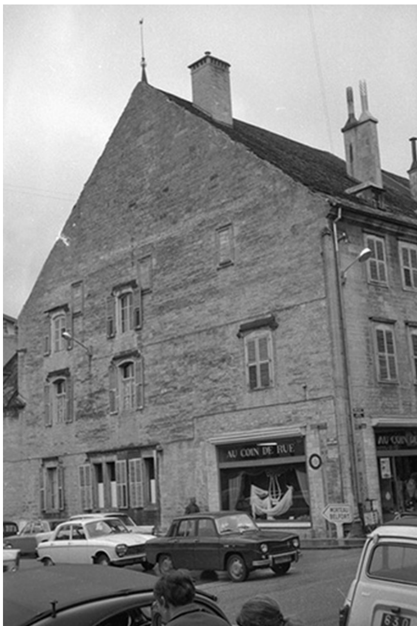
Façade latérale gauche en 1968.
