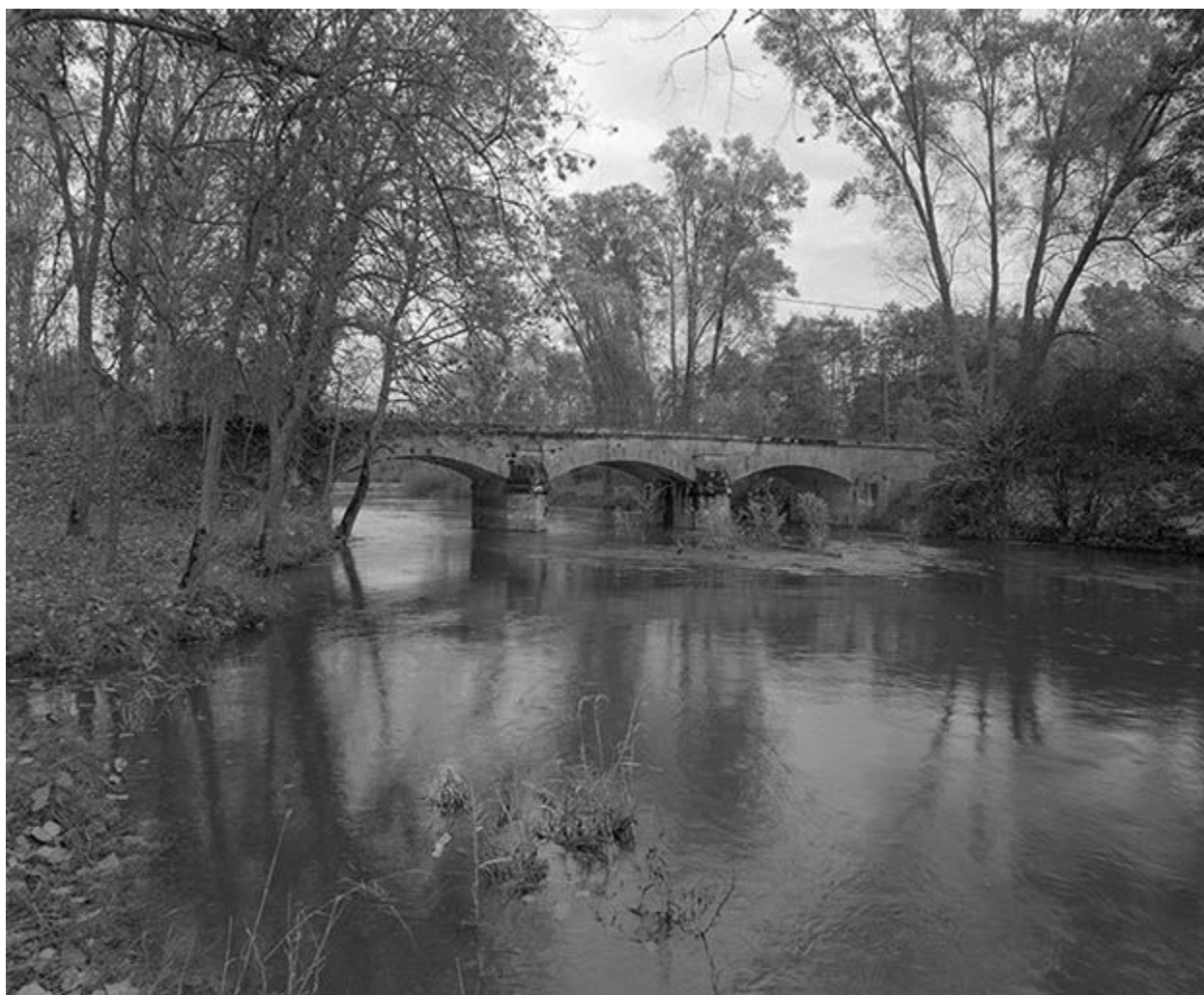
Vue prise depuis l'amont
