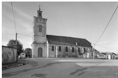
Extérieur : face latérale sud.
