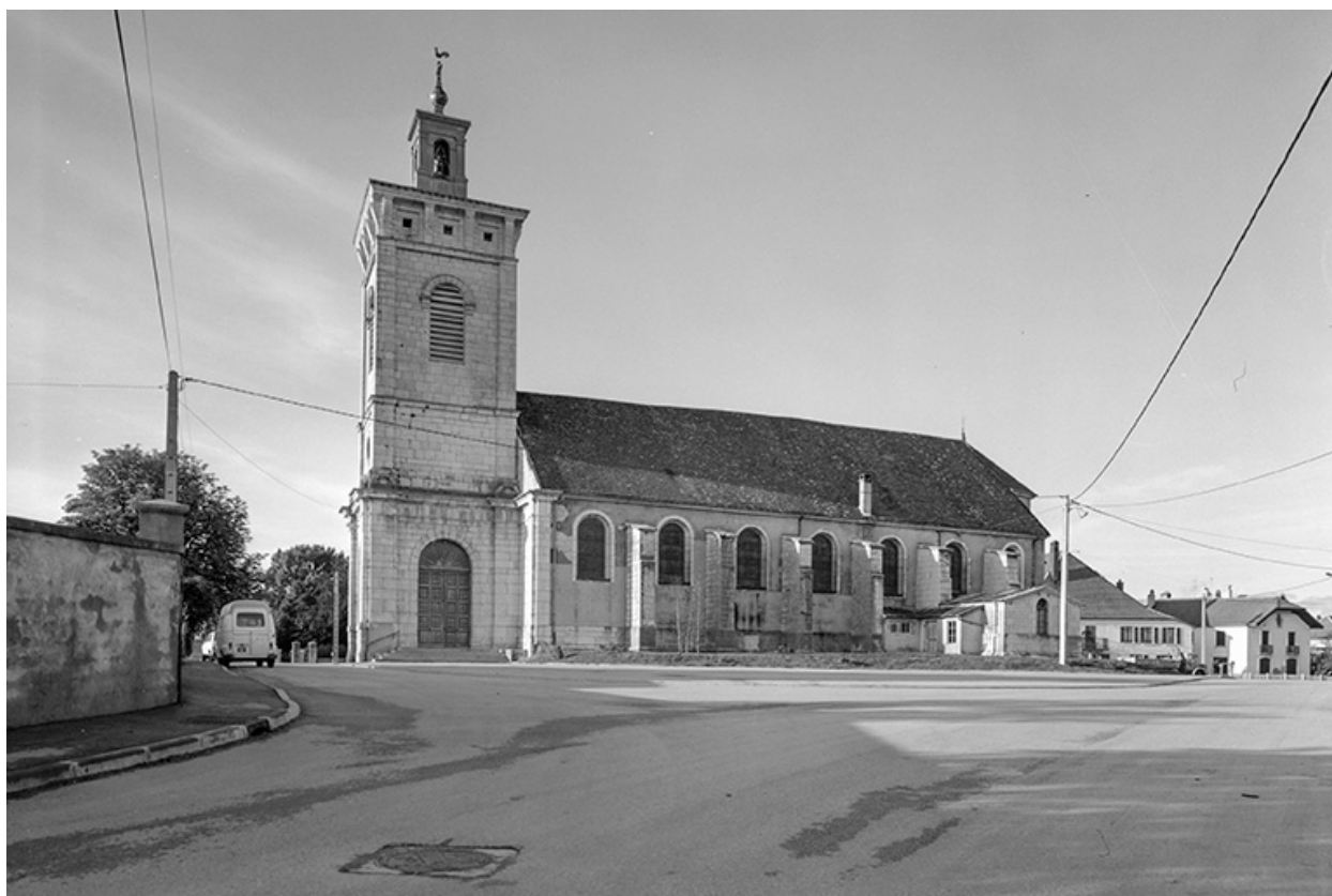
Extérieur : face latérale sud.
