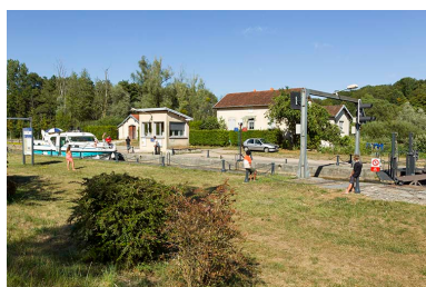
Vue d'ensemble du site d'écluse. Phot. Sonia Dourlot IVR43_20157000762NUC2A
