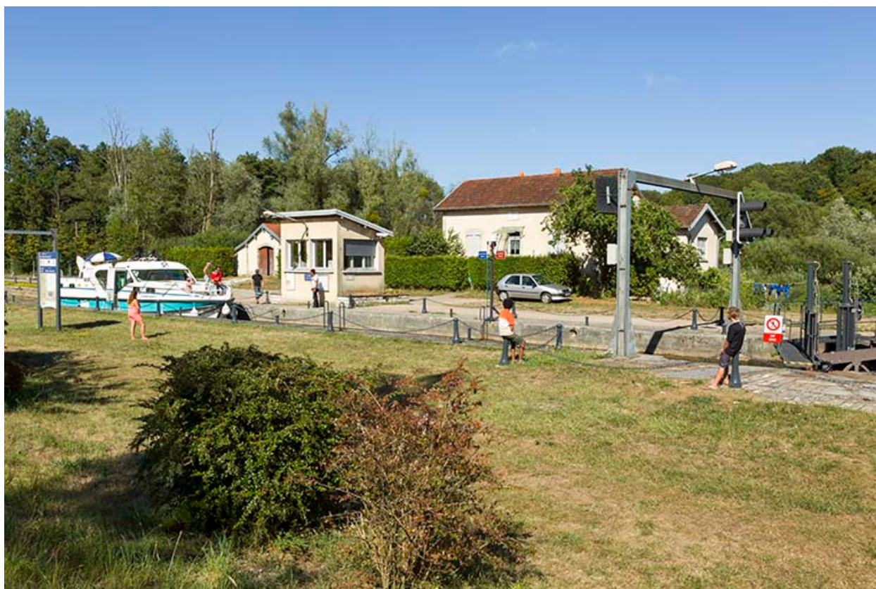
Vue d'ensemble du site d'écluse.
