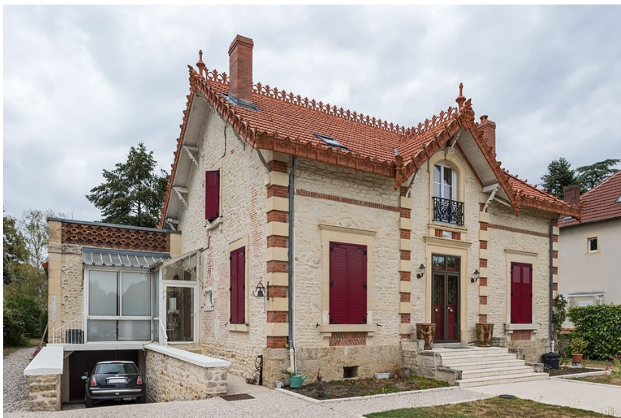
Façade principale, vue de trois quarts.
