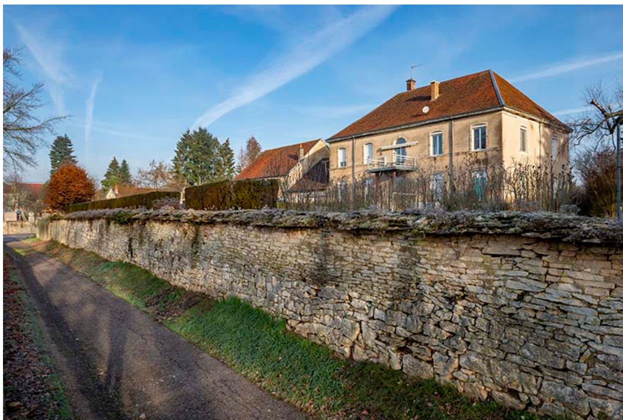
La façade postérieure.
