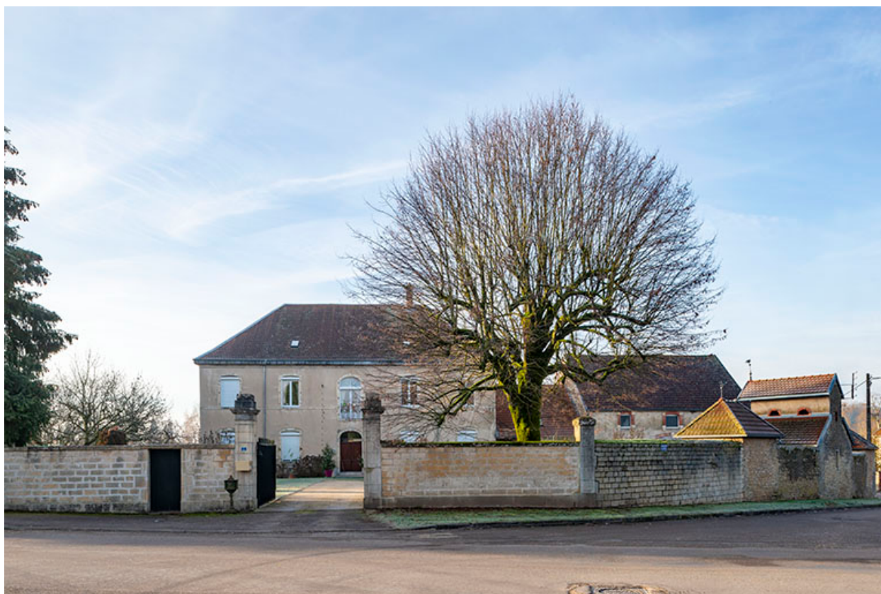
Vue générale depuis la route de Ferrières.
