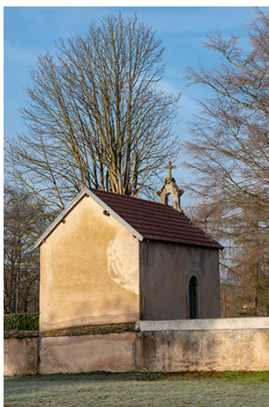
La chapelle, détail. Phot. Jérôme Mongreville IVR43_20197000091NUC4A
