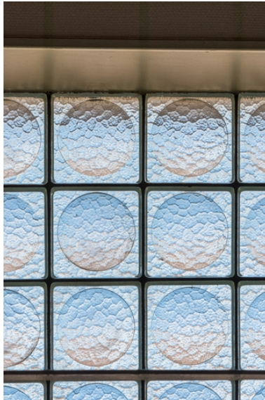
Cage d'escalier : détail des pavés de verre.
