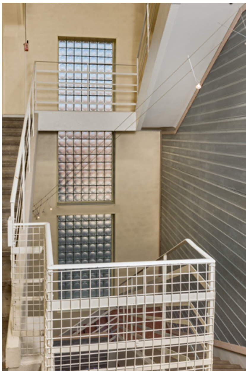
Cage d'escalier, depuis le 1er étage.
