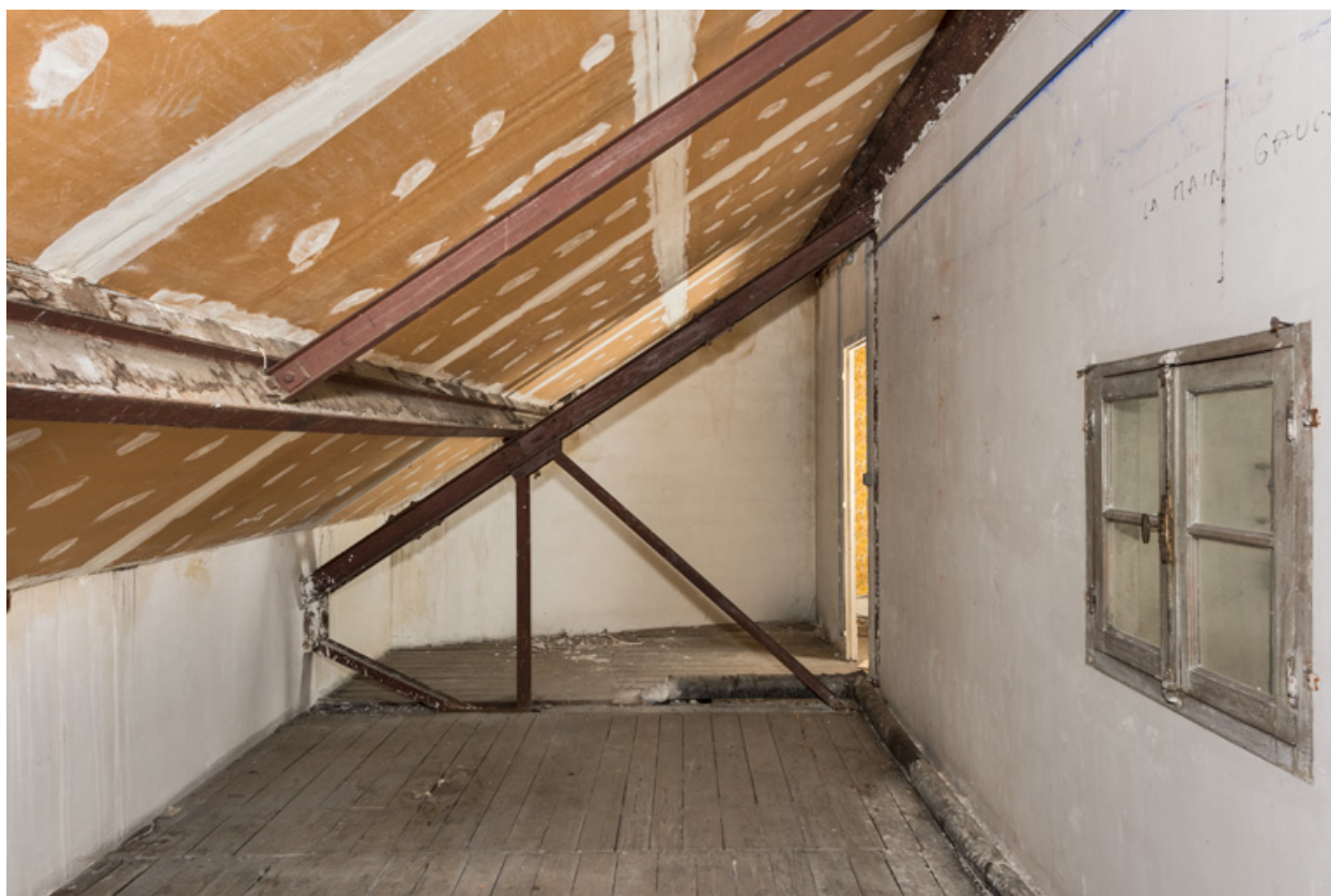
2e étage : charpente métallique.
