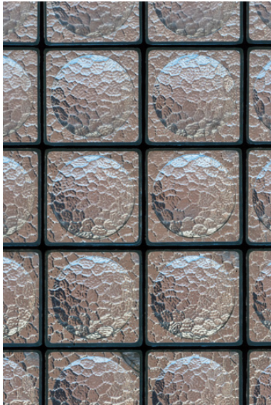
Cage d'escalier : détail des pavés de verre.
