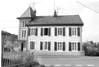
maison , rue de la maison Blanche. Phot. Bernard Lardière IVR43_19829000154Z
