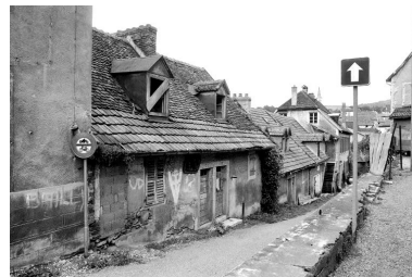
Alignement de maisons d'ouvriers, rue de la Poste Phot. Bernard Lardière IVR43_19829000127Z
