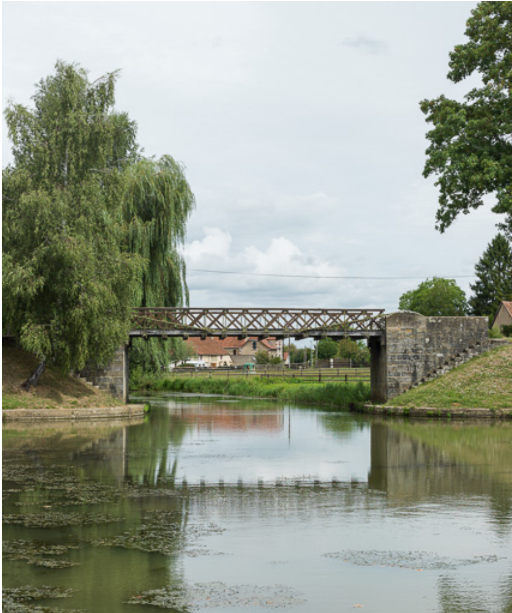
Vue d'ensemble de la passerelle.
