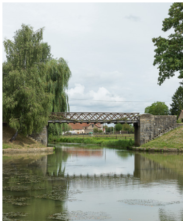
Vue d'ensemble de la passerelle.
