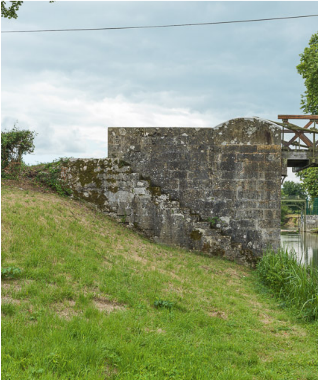
Détail d'une culée en moellons.
