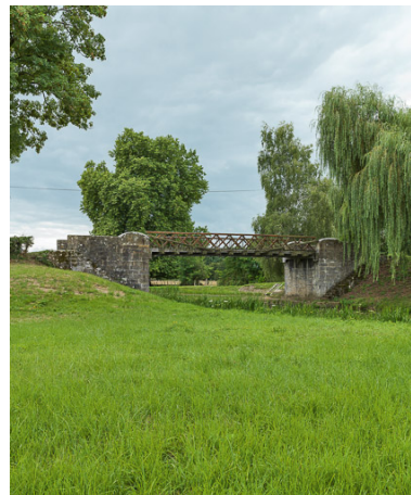
Vue de la passerelle.
