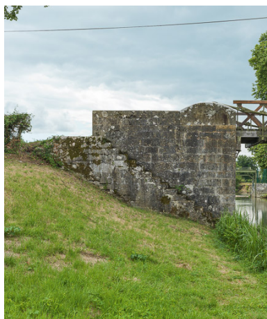
Détail d'une culée en moellons.
