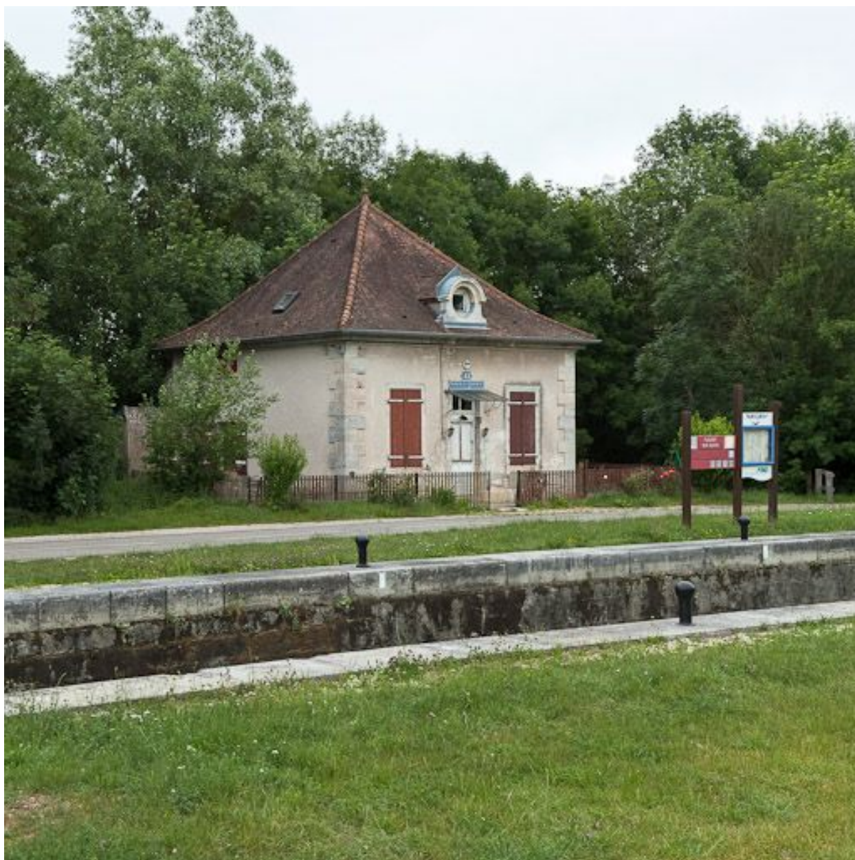
Vue du site d'écluse.
