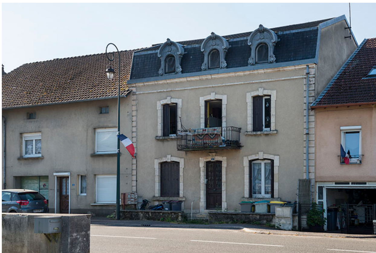
Maison n° 6, vue de trois quarts gauche.
