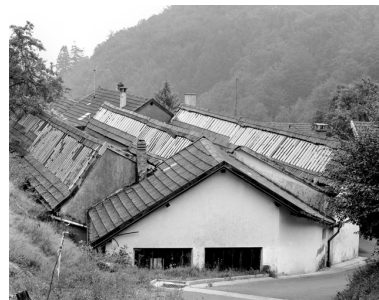
Sheds de l'atelier de fabrication depuis l'ouest.
