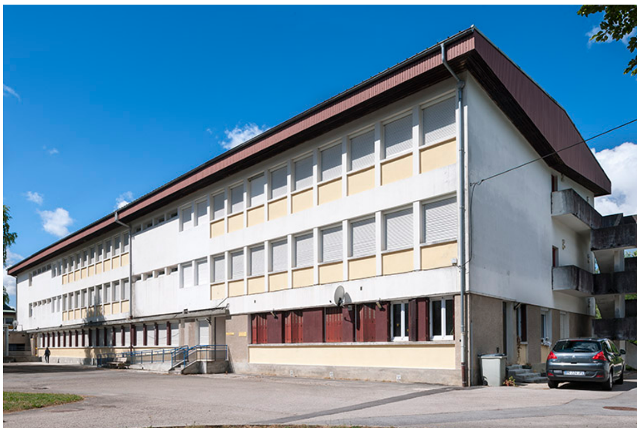
Internat : façade antérieure.
