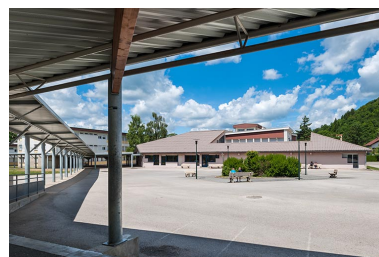
Restauration : vue d'ensemble, extension et bâtiment initial. Phot. Jérôme Mongreville IVR43_20143900510NUC4A
