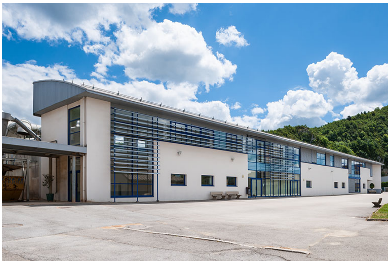
Ateliers, façade antérieure.
