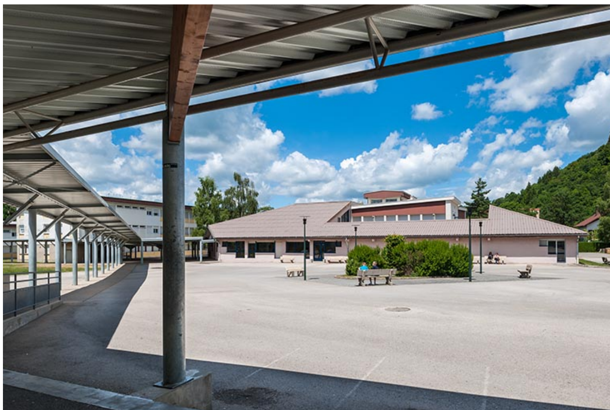
Restauration : vue d'ensemble, extension et bâtiment initial.
