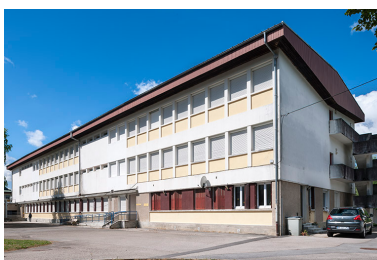
Internat : façade antérieure. Phot. Jérôme Mongreville IVR43_20143900500NUC4A
