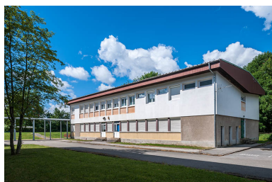
Externat : façade antérieure. Phot. Jérôme Mongreville IVR43_20143900501NUC4A
