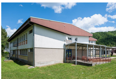
Externat : pignon sud. Phot. Jérôme Mongreville IVR43_20143900505NUC4A
