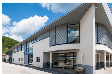
Ateliers : détail des façades et entrée. Phot. Jérôme Mongreville IVR43_20143900483NUC4A
