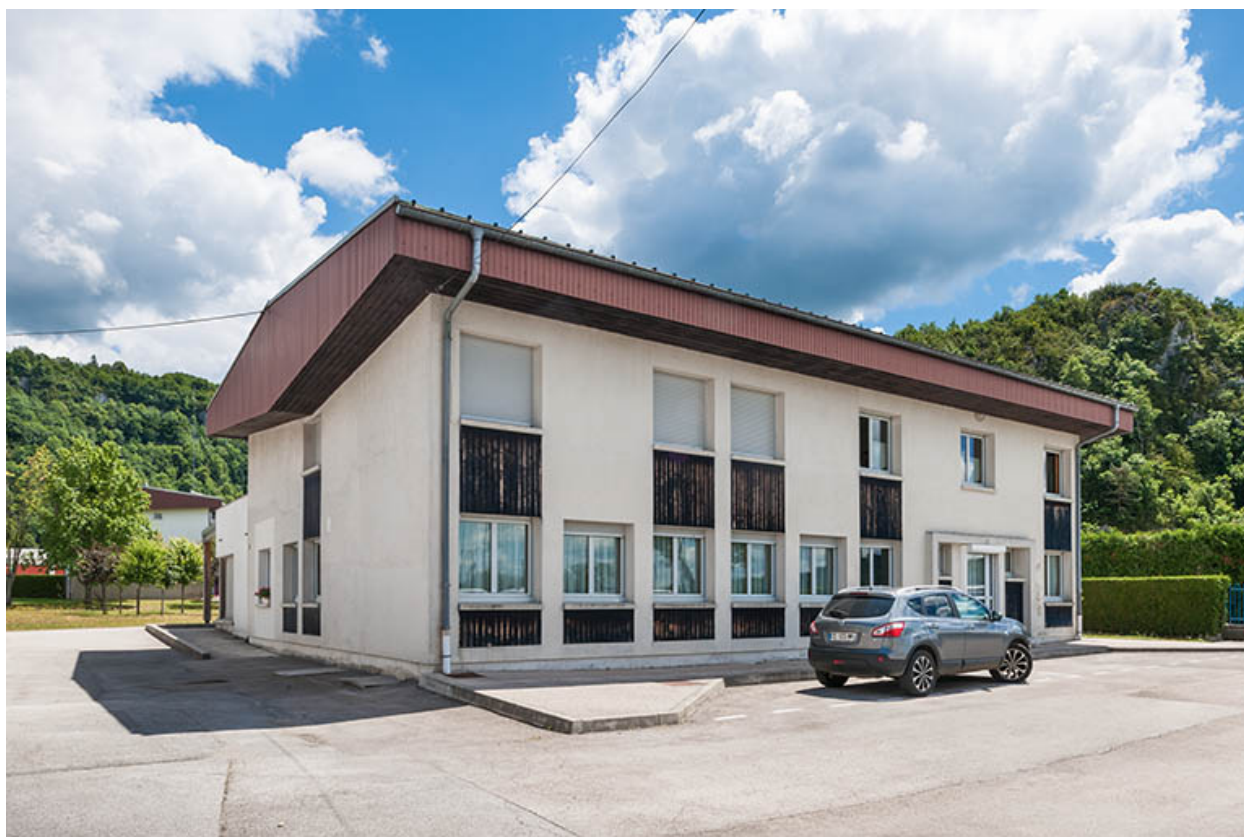
Administration, façade postérieure.
