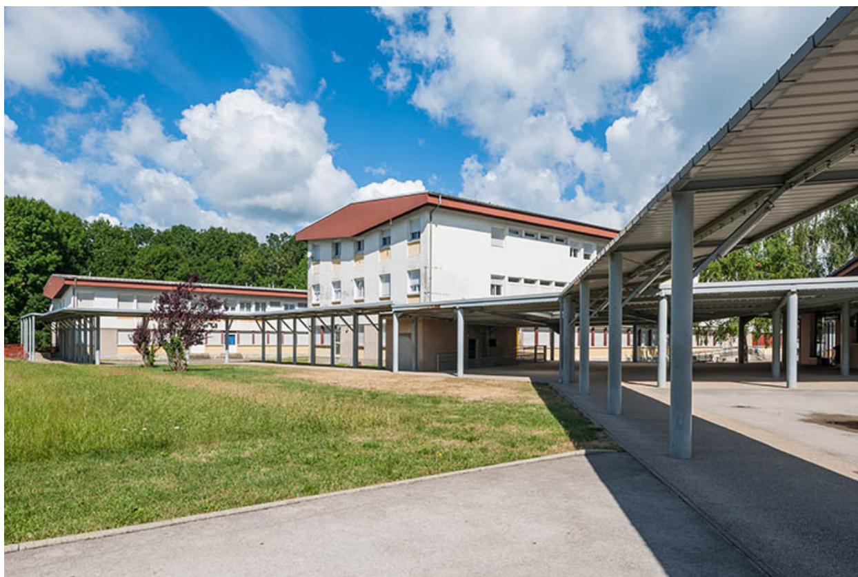
Circulations couvertes entre externat, internat et restauration.
