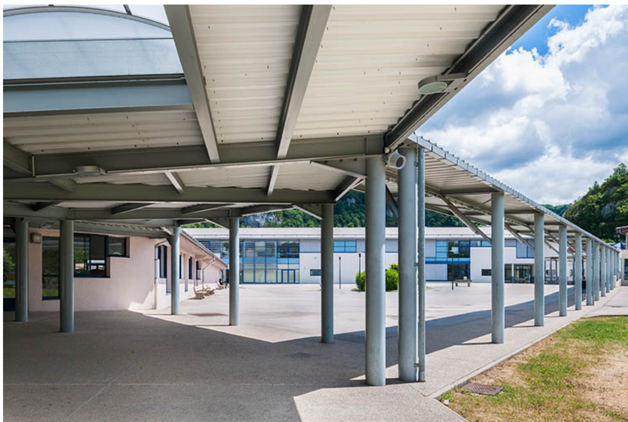
Passage entre internat et restauration.
