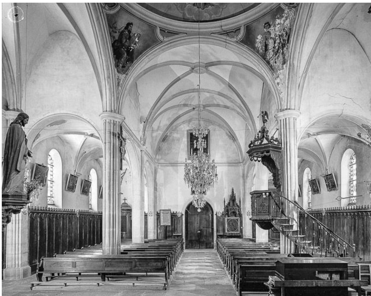
Intérieur : la nef vue depuis le chœur.
