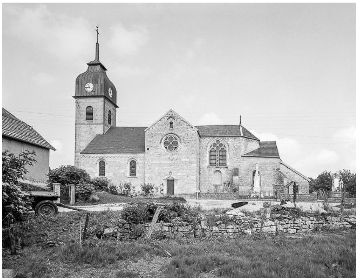
Façade latérale droite.
