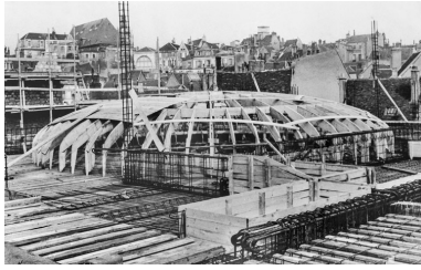
1er tableau : [2C] La coupole en construction, 1938.
