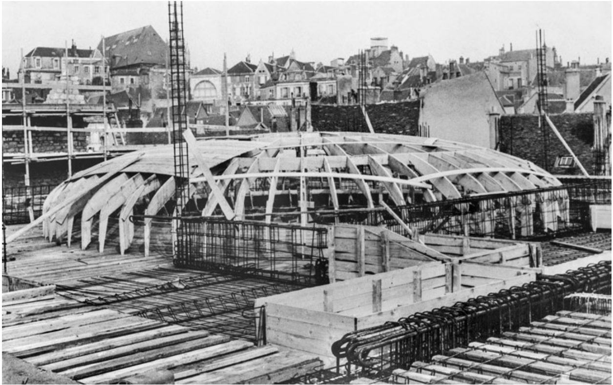
1er tableau : [2C] La coupole en construction, 1938.
