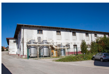
Bâtiments sud : façade latérale gauche. Phot. Yves Sancey IVR43_20132502404NUC2A
