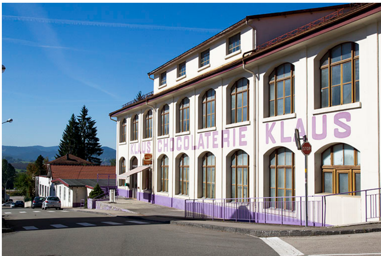
Bâtiments nord et sud : façade antérieure, de trois quarts droite.
