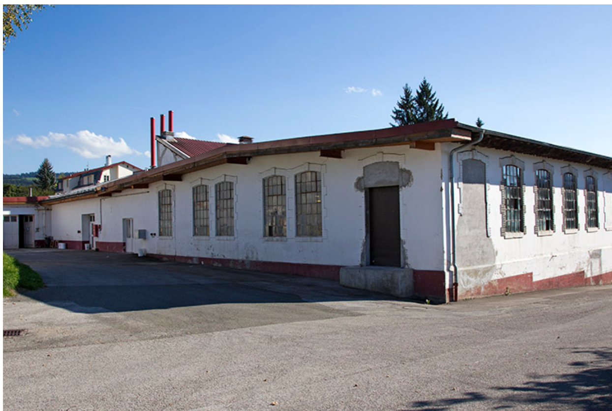
Bâtiments sud : façades postérieure et latérale droite.
