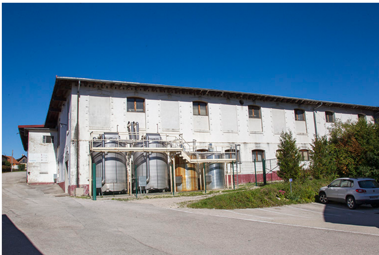
Bâtiments sud : façade latérale gauche.
