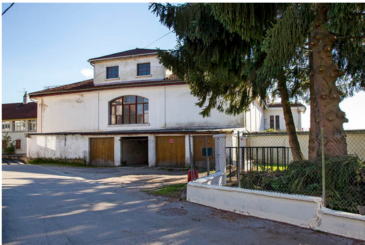
Bâtiment nord : façade latérale droite.
