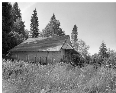
Vue éloignée de trois quarts gauche. Phot. Yves Sancey IVR43_19993900397X
