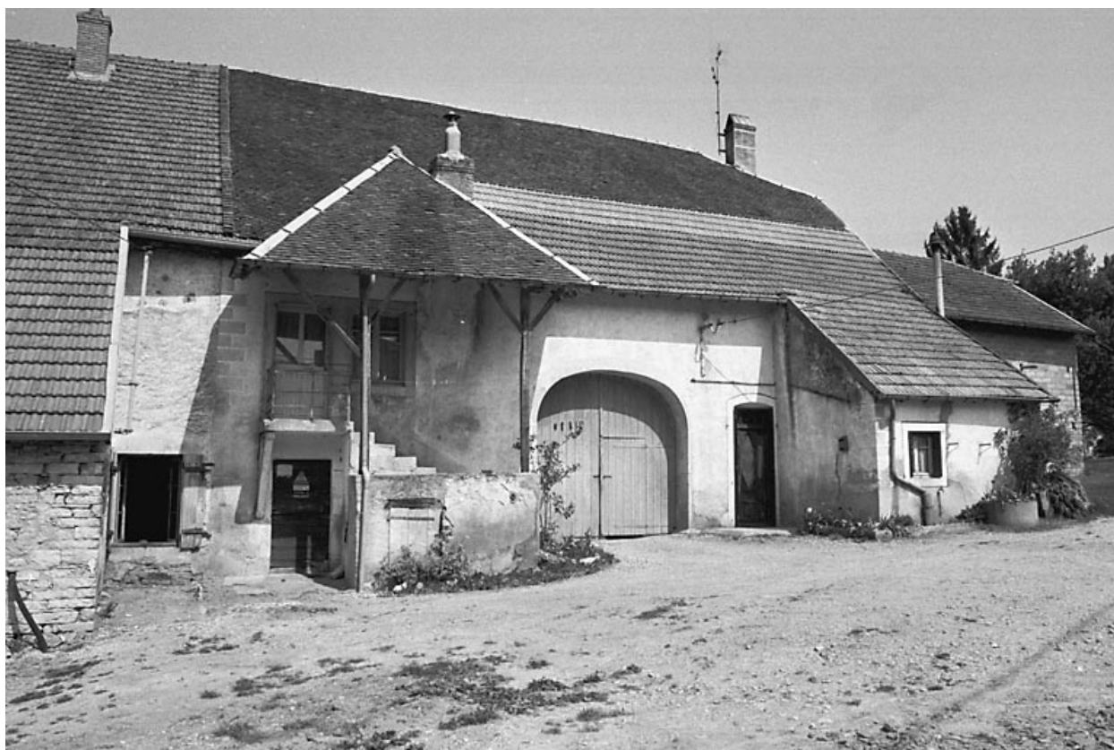
Façade antérieure : vue rapprochée.
