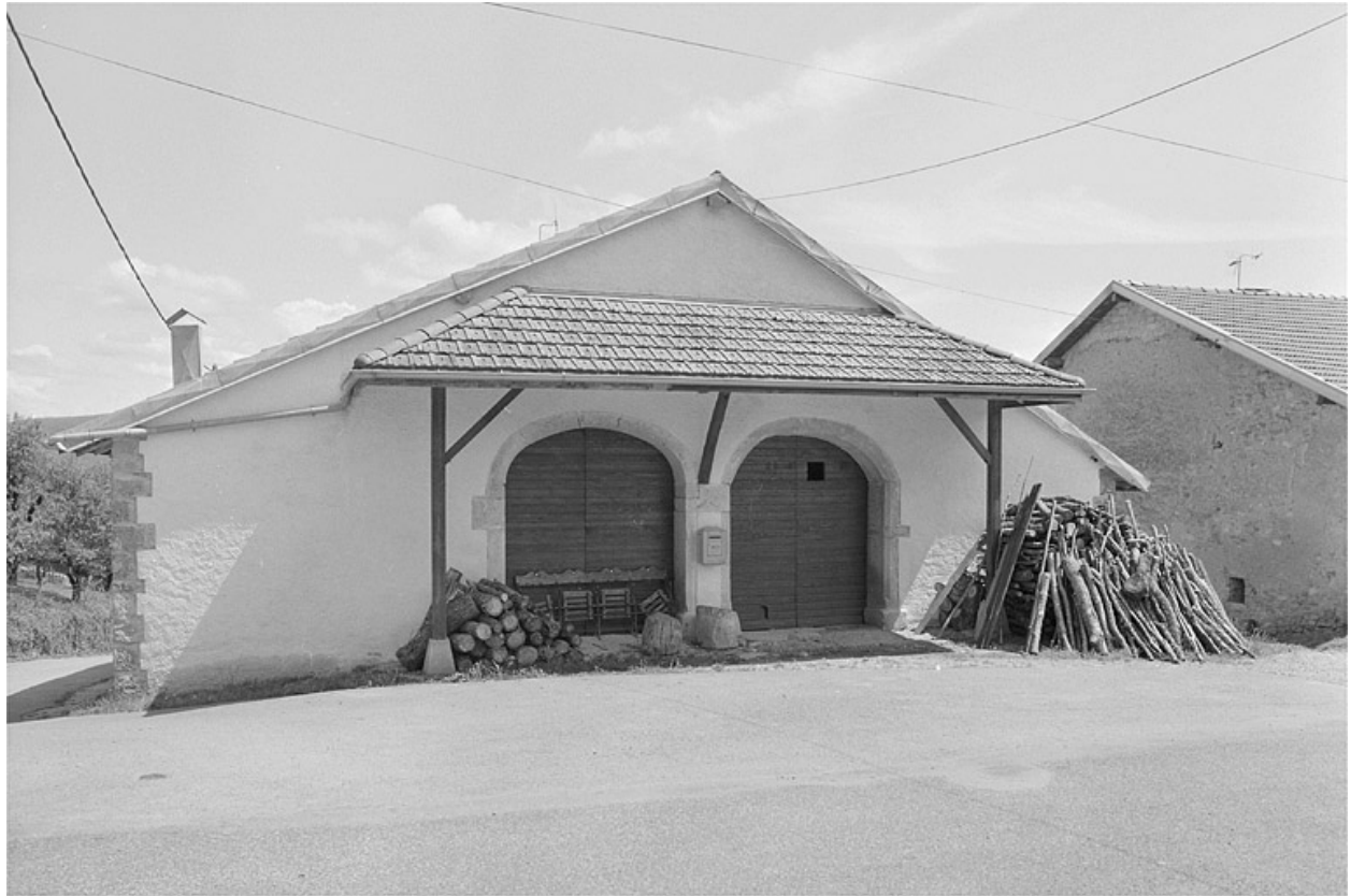
Façade postérieure avec granges hautes.
