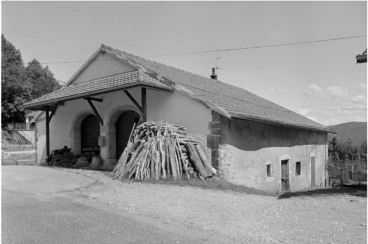
Façade postérieure et face sud.
