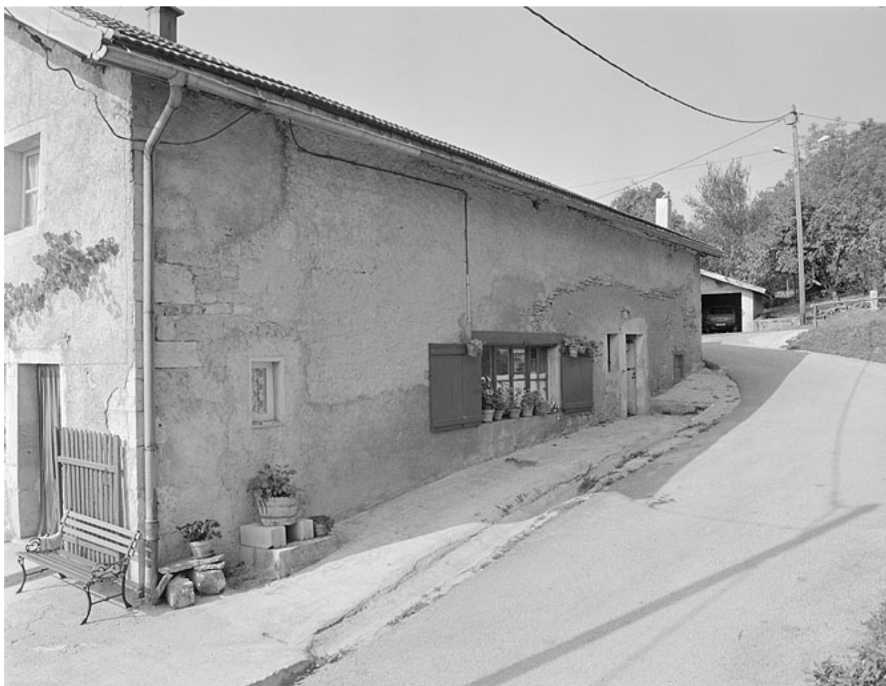
Atelier installé dans une partie de l'étable.
