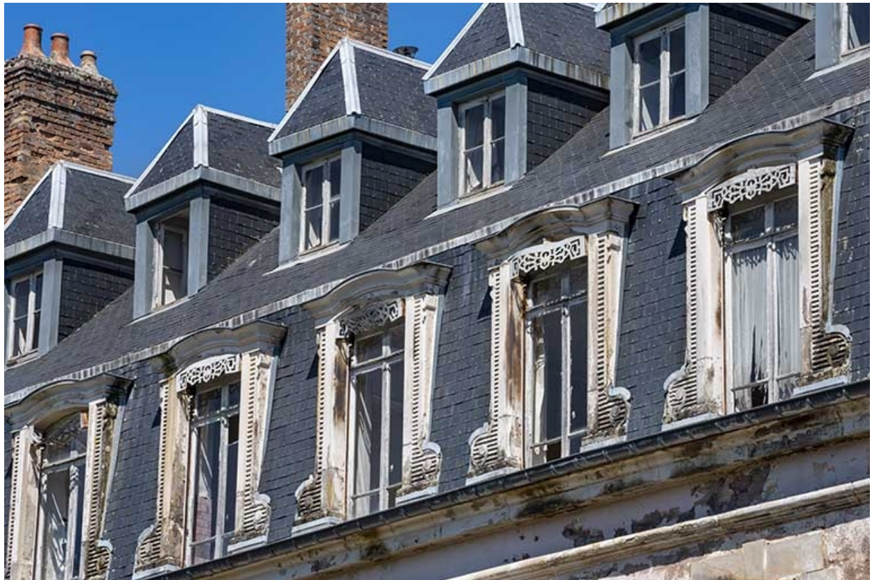
Façade sud, lucarnes.
