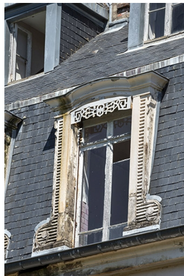
Façade sud, lucarne. Phot. Jérôme Mongreville IVR43_20207000583NUC4A
