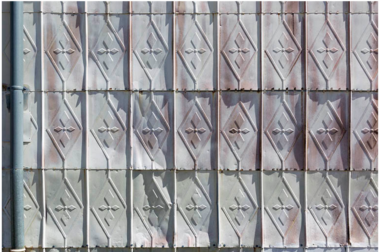
Façade latérale droite : essentage de tôle.
