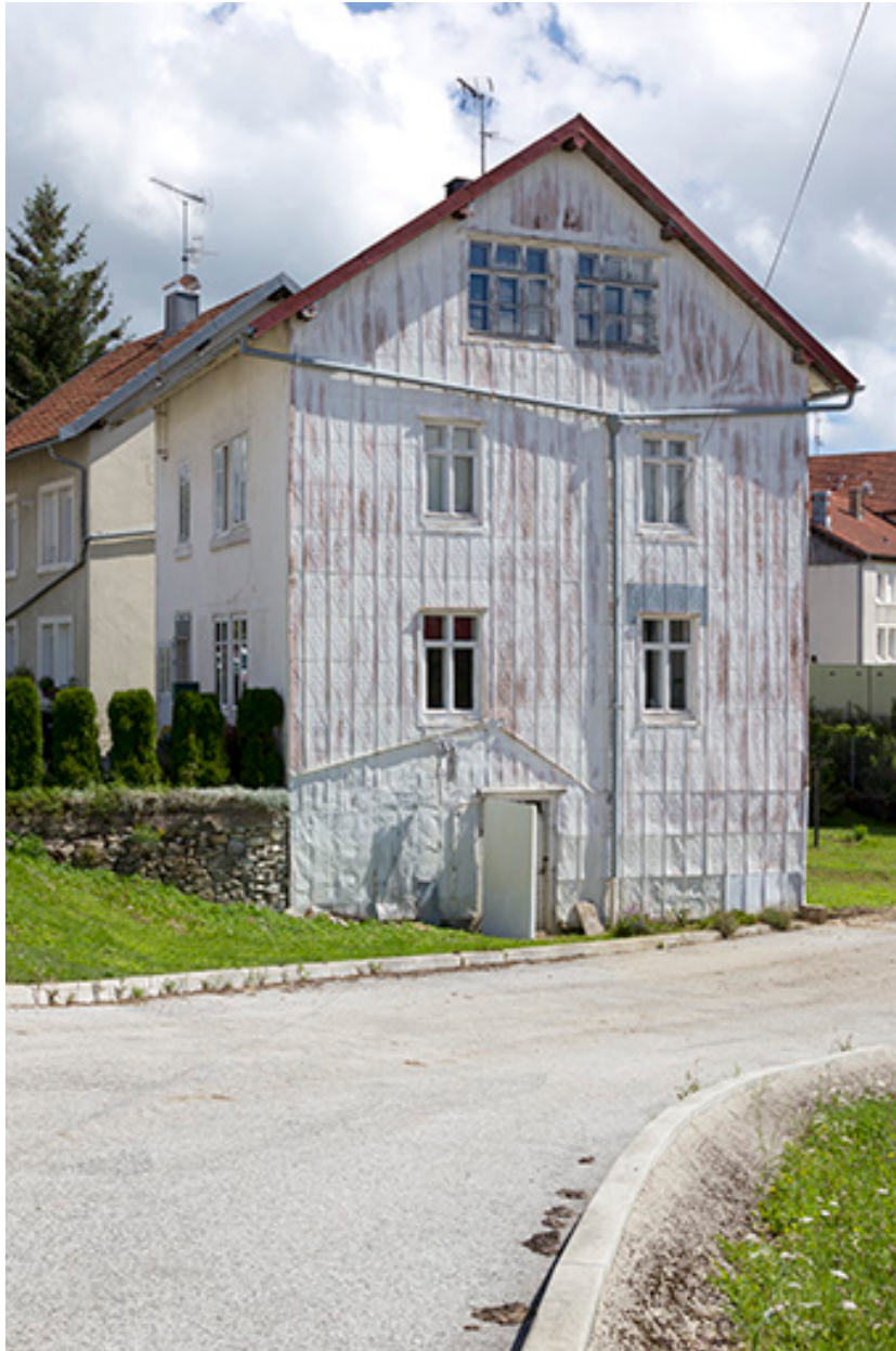
Façade latérale droite, de trois quarts gauche.
