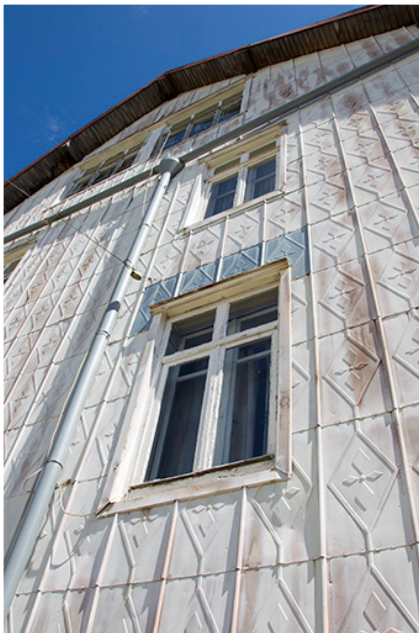
Façade latérale droite : fenêtres vues en contre-plongée.
