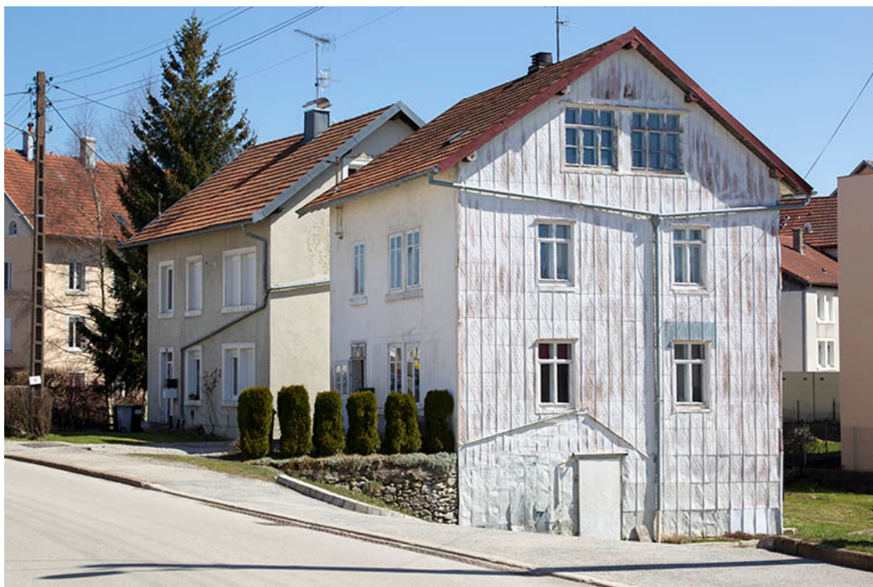
Vue d'ensemble, depuis l'ouest et la rue de la Gare.
