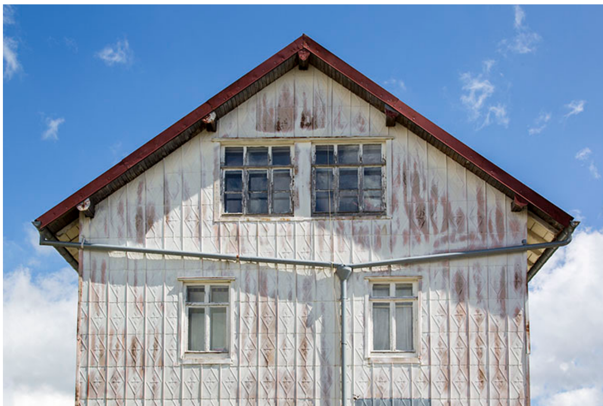
Façade latérale droite : fenêtres des niveaux supérieurs.
