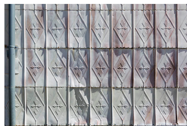
Façade latérale droite : essentage de tôle. Phot. Sonia Dourlot IVR43_20152500780NUC2A
