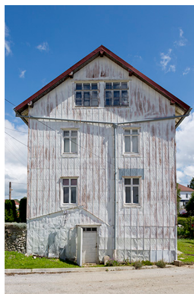
Façade latérale droite. Phot. Sonia Dourlot IVR43_20152500782NUC2A
