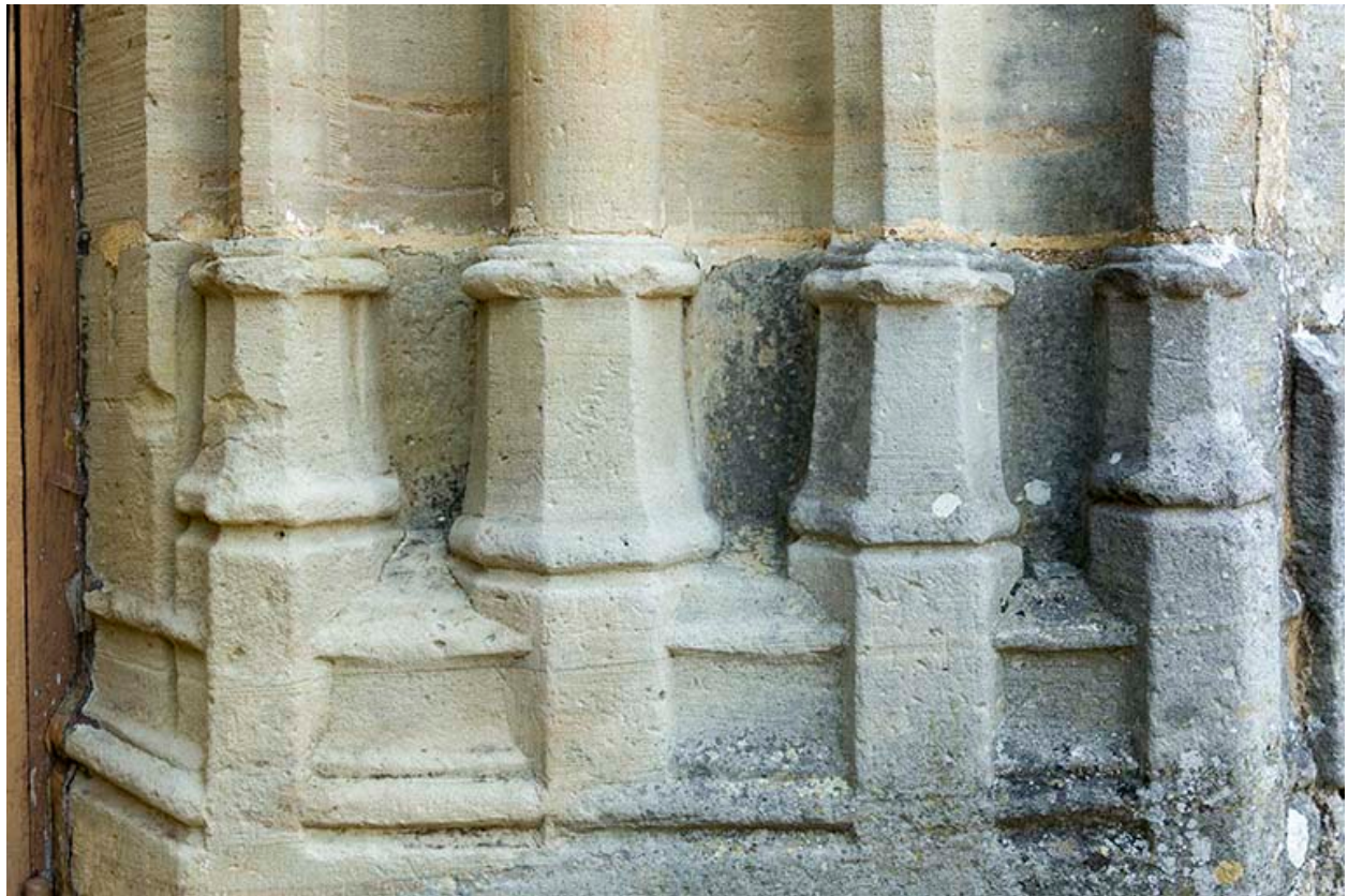
Détail de la base du piedroit droit.
