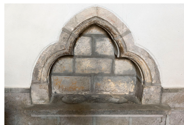
Détail : niche trilobée à droite du choeur. Phot. Sonia Dourlot IVR43_20157001362NUC4A
