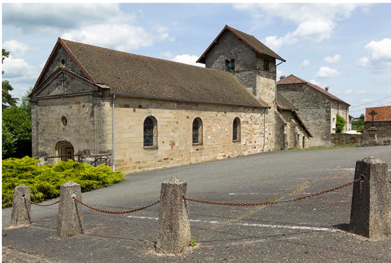
Vue de trois quart depuis le sud-ouest.
