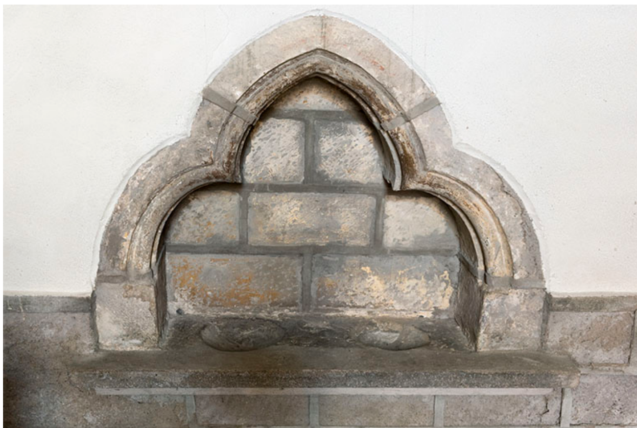
Détail : niche trilobée à droite du chœur.
