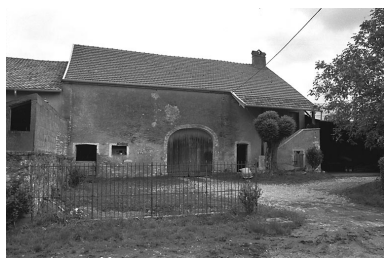
Façade antérieure sur cour.
