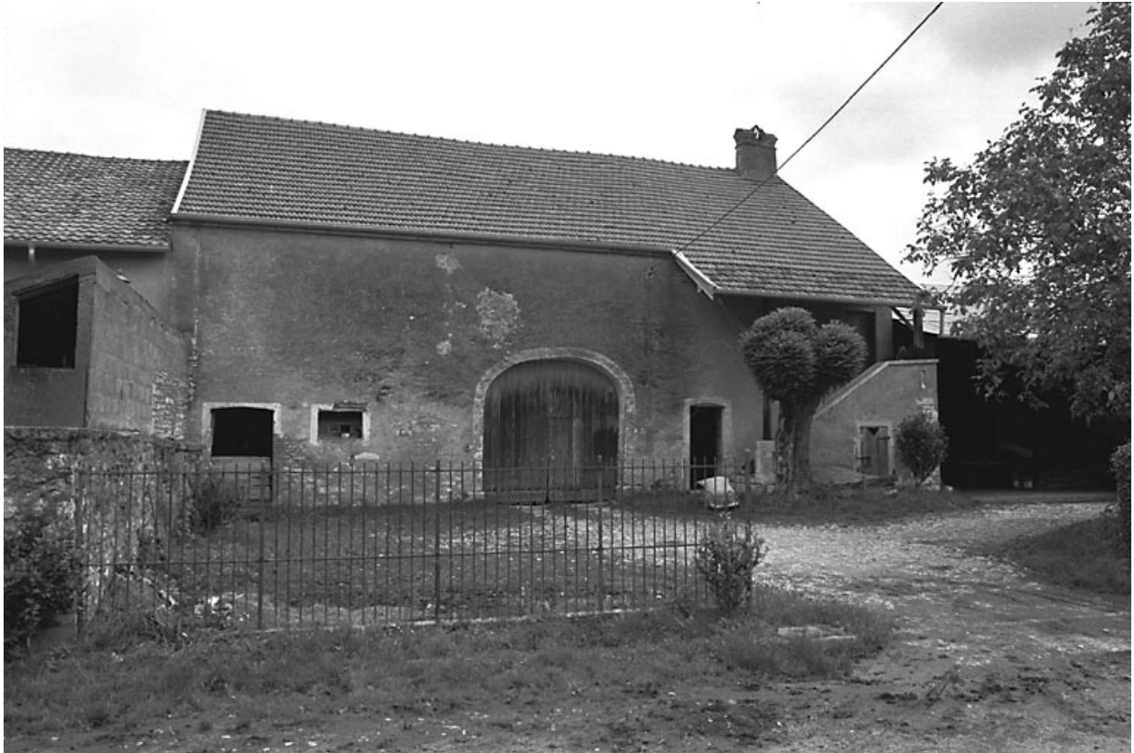
Façade antérieure sur cour.
