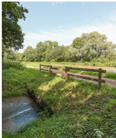
Vue de l'aqueduc.
