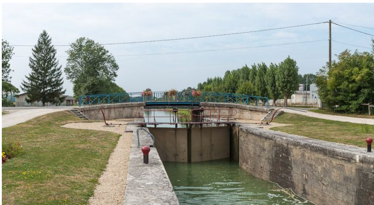
Vue du pont depuis le sas.
