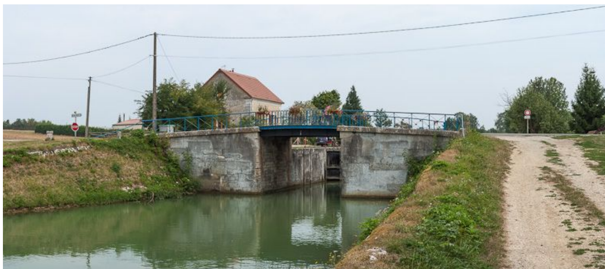
Le pont vu d'aval.
