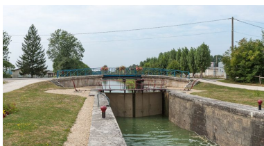
Vue du pont depuis le sas. Phot. Pierre-Marie Barbe-Richaud
