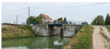
Le pont vu d'aval. Phot. Pierre-Marie Barbe-Richaud IVR26_20128900571NUC4AQ
