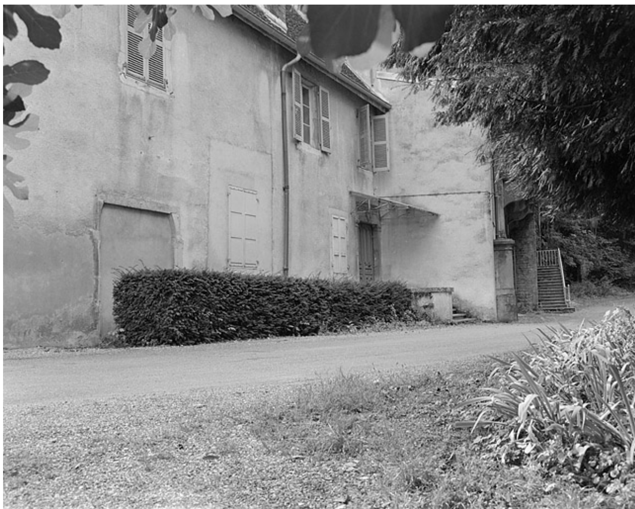
Façade latérale droite du bâtiment A.
