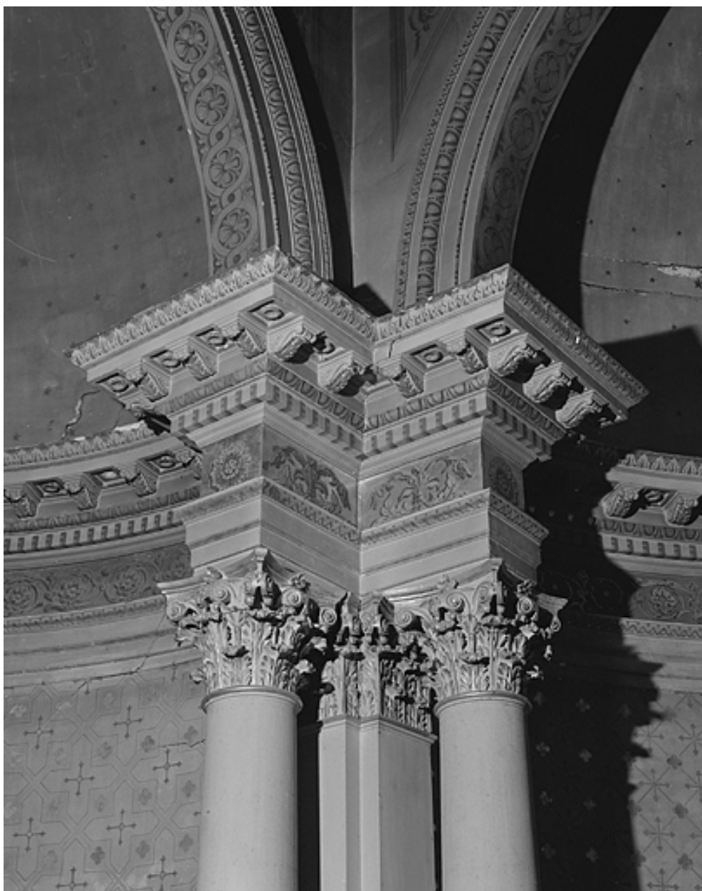
Chapelle II, détail de l'entablement du chœur.
