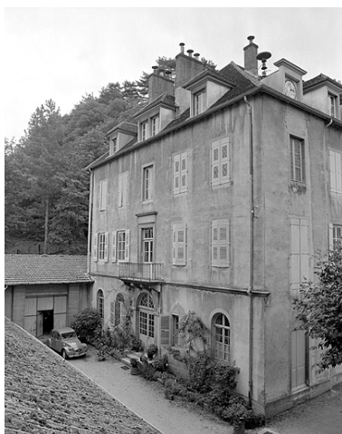
Façade antérieure du bâtiment C.
