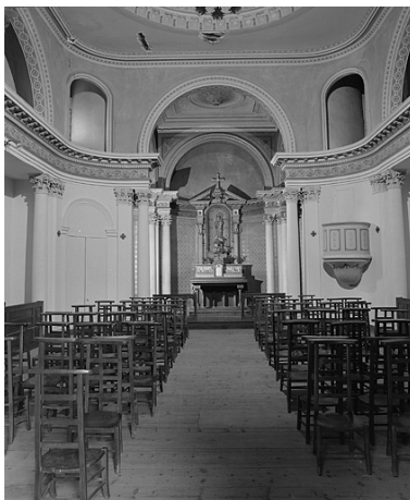
Chapelle II, vaisseau vu depuis l'entrée. Phot. Yves Sancey IVR43_19833900353X
