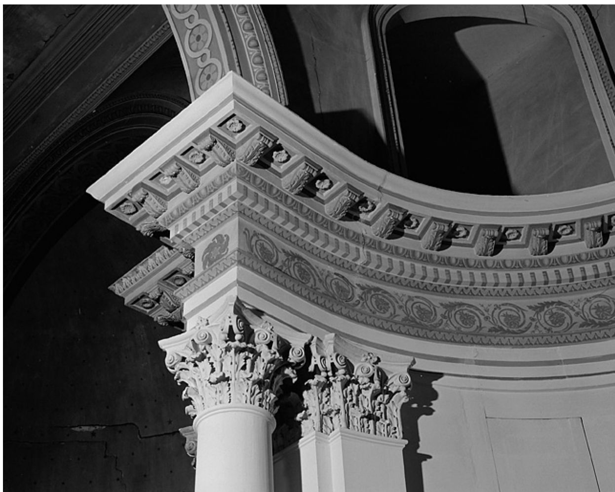
Chapelle II, détail de l'entablement du vaisseau.
