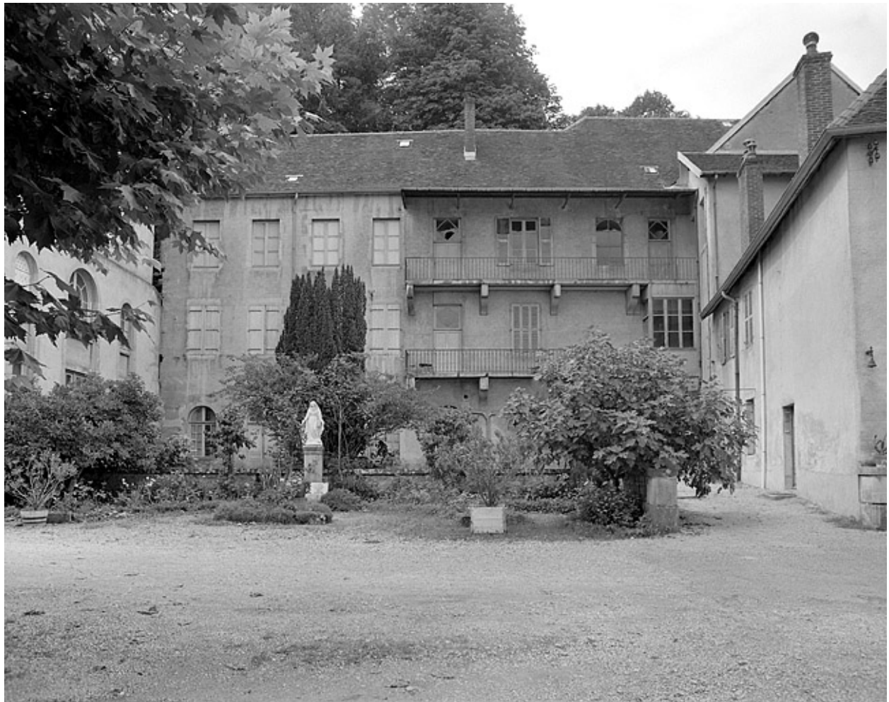
Façade latérale du bâtiment B.
