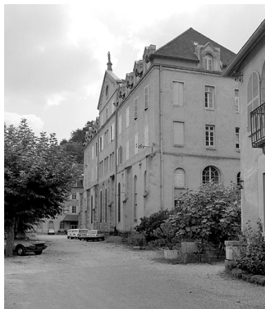
Vue de trois-quarts du bâtiment D. Phot. Yves Sancey IVR43_19833900351X
