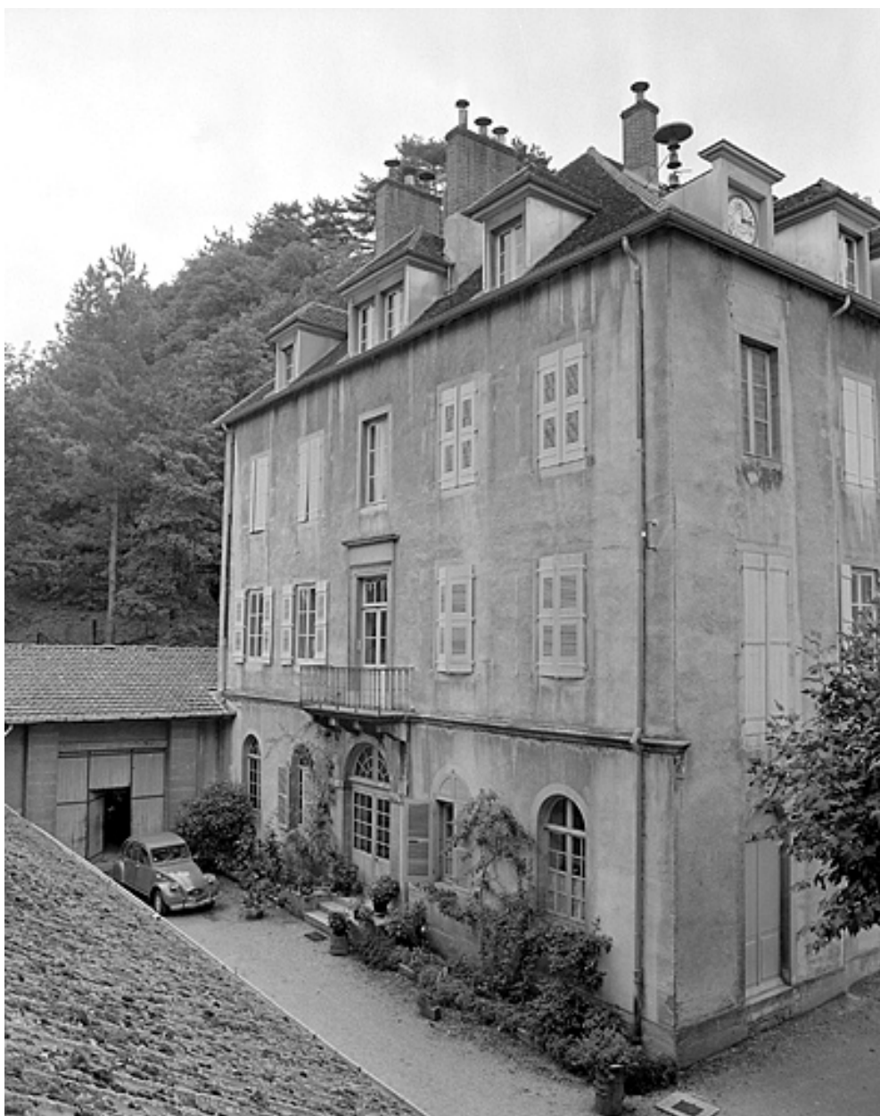
Façade antérieure du bâtiment C.
