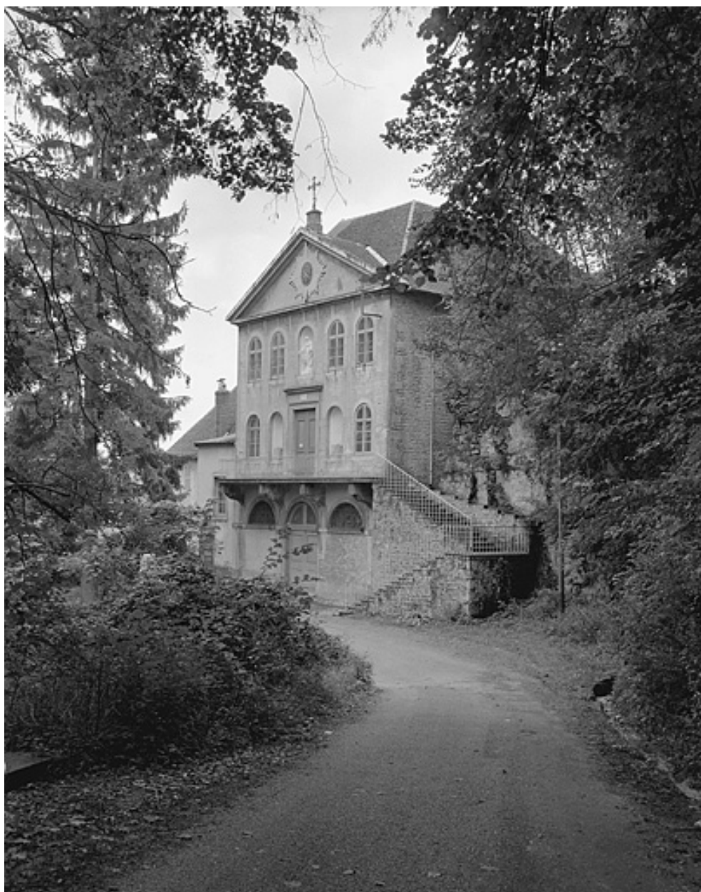
Façade antérieure du bâtiment B.
