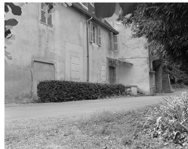
Façade latérale droite du bâtiment A. Phot. Yves Sancey IVR43_19833900345X
