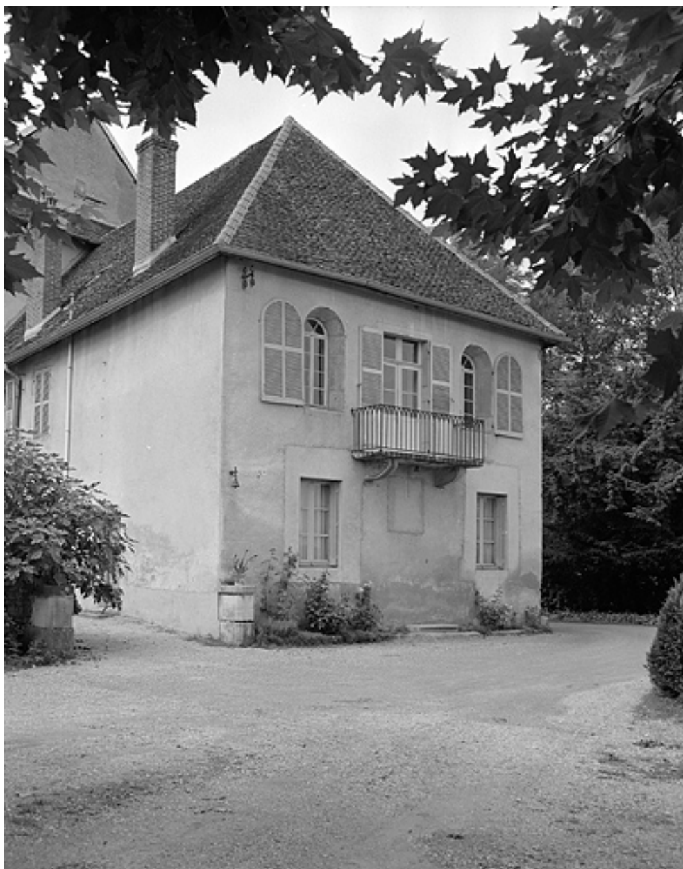
Façade antérieure du bâtiment A.
