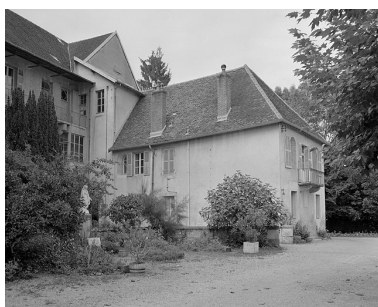
Façade latérale gauche du bâtiment A. Phot. Yves Sancey IVR43_19833900347X
