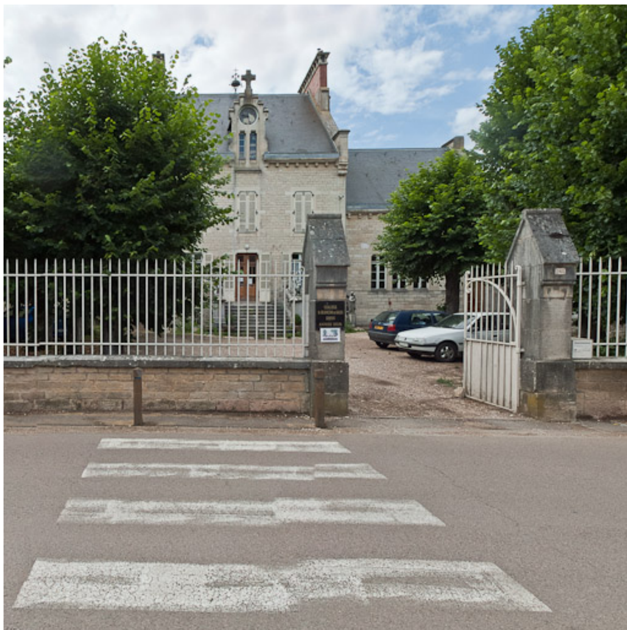
Vue du pensionnat depuis la route.
