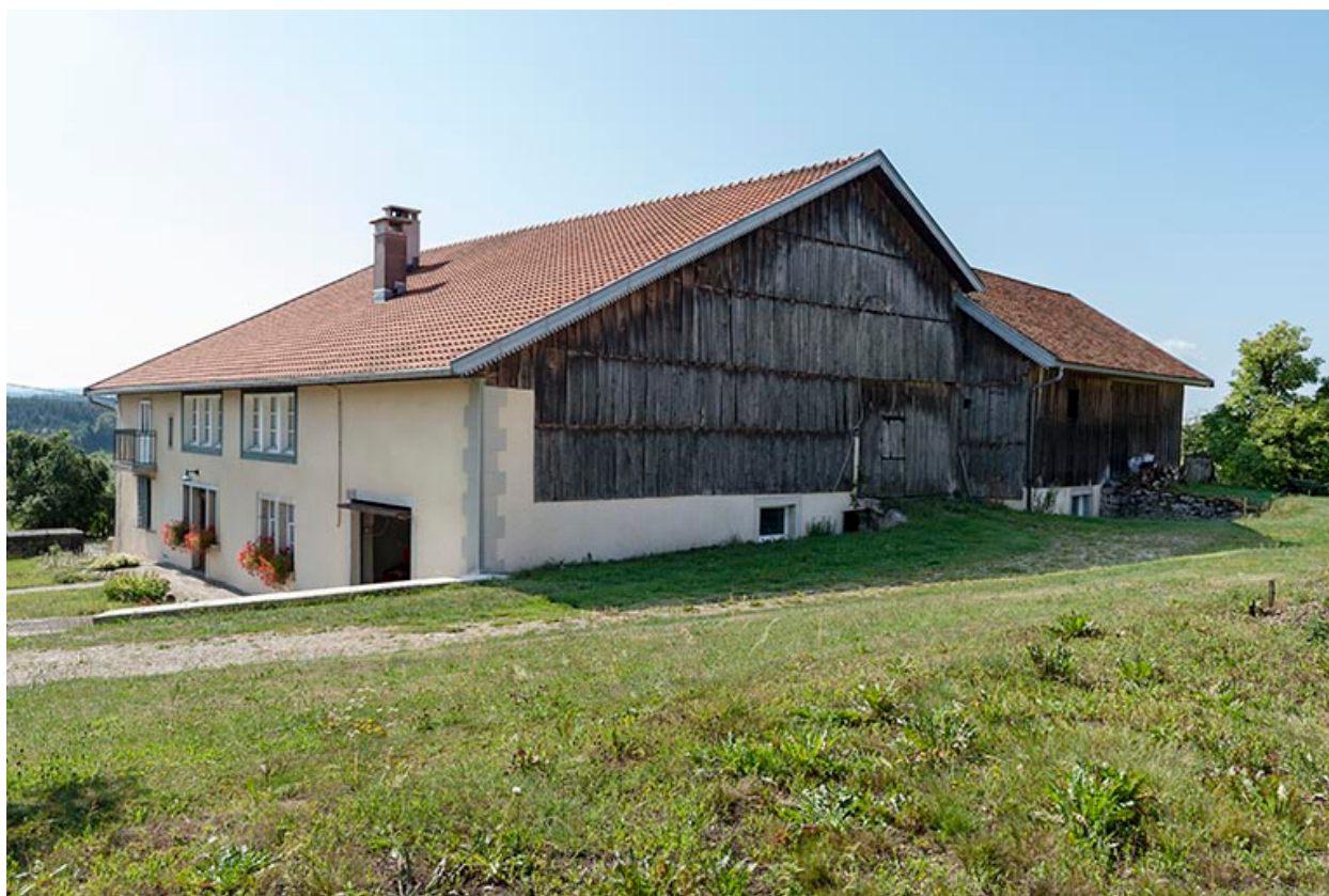
Façades antérieure et latérale droite.
