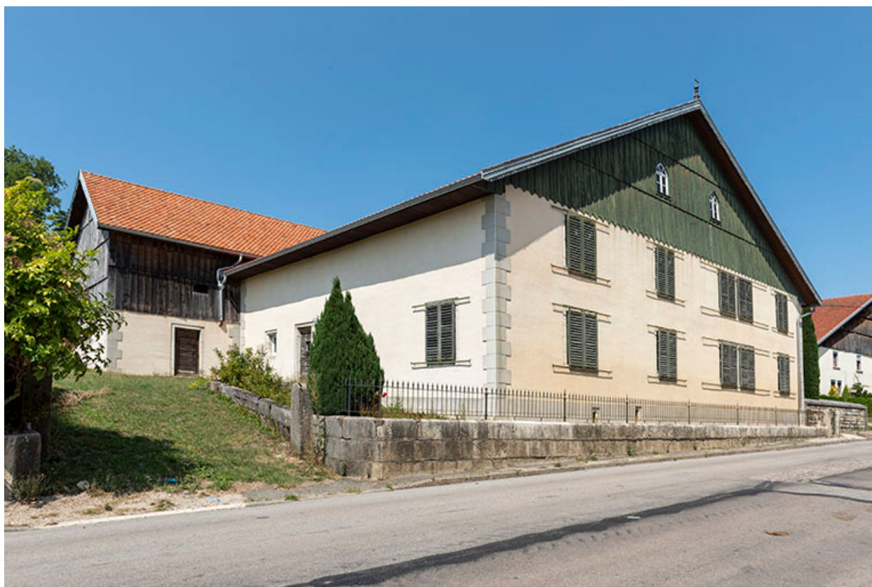
Façades postérieure et latérale gauche.
