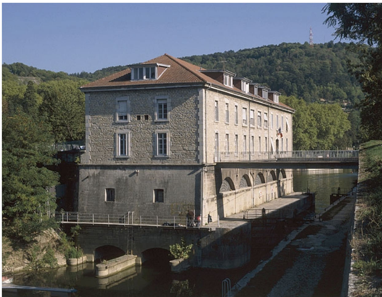
Le moulin de trois quarts gauche (aval).
