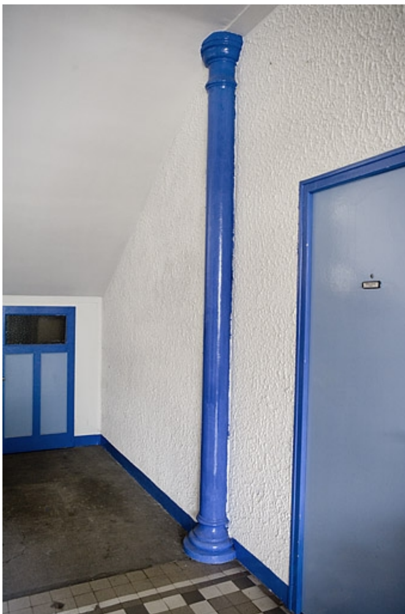
Intérieur de l'entrée : poteau en fonte.
