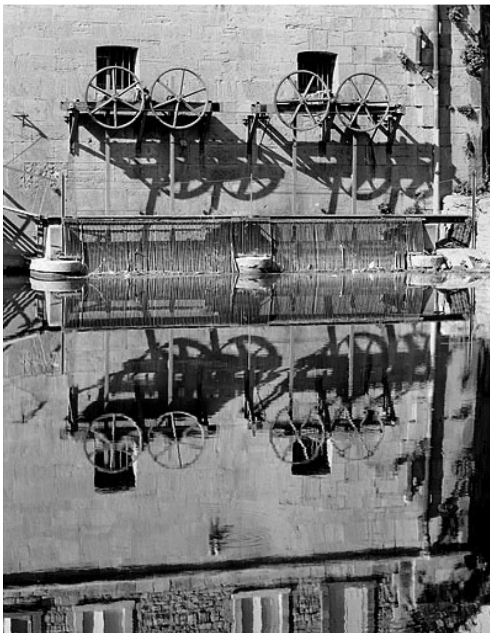
Vannes de prise d'eau à l'amont.
