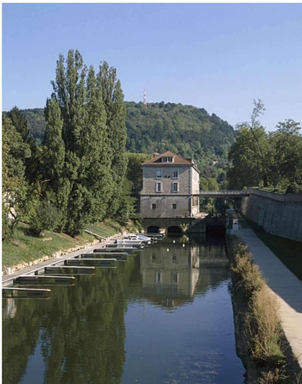
Vue d'ensemble depuis l'aval.
