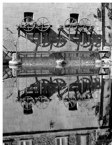
Vannes de prise d'eau à l'amont. Phot. Jérôme Mongreville IVR43_20032500205X
