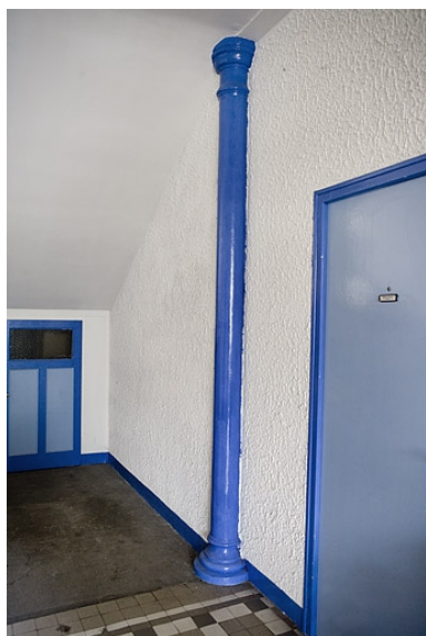
Intérieur de l'entrée : poteau en fonte.
