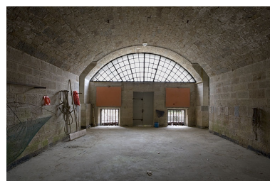
Intérieur d'une casemate : baie. Phot. Yves Sancey IVR43_20062500257NUCA
