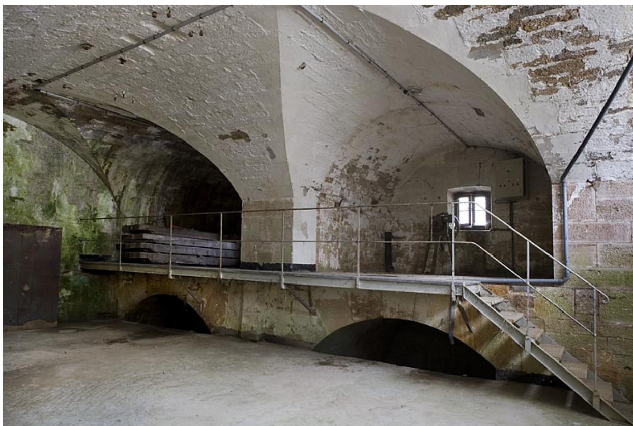
Intérieur de la casemate amont : coursiers voûtés.
