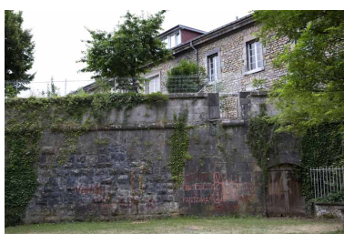
Face ouest du bastion. Phot. Yves Sancey IVR43_20062500303NUCA
