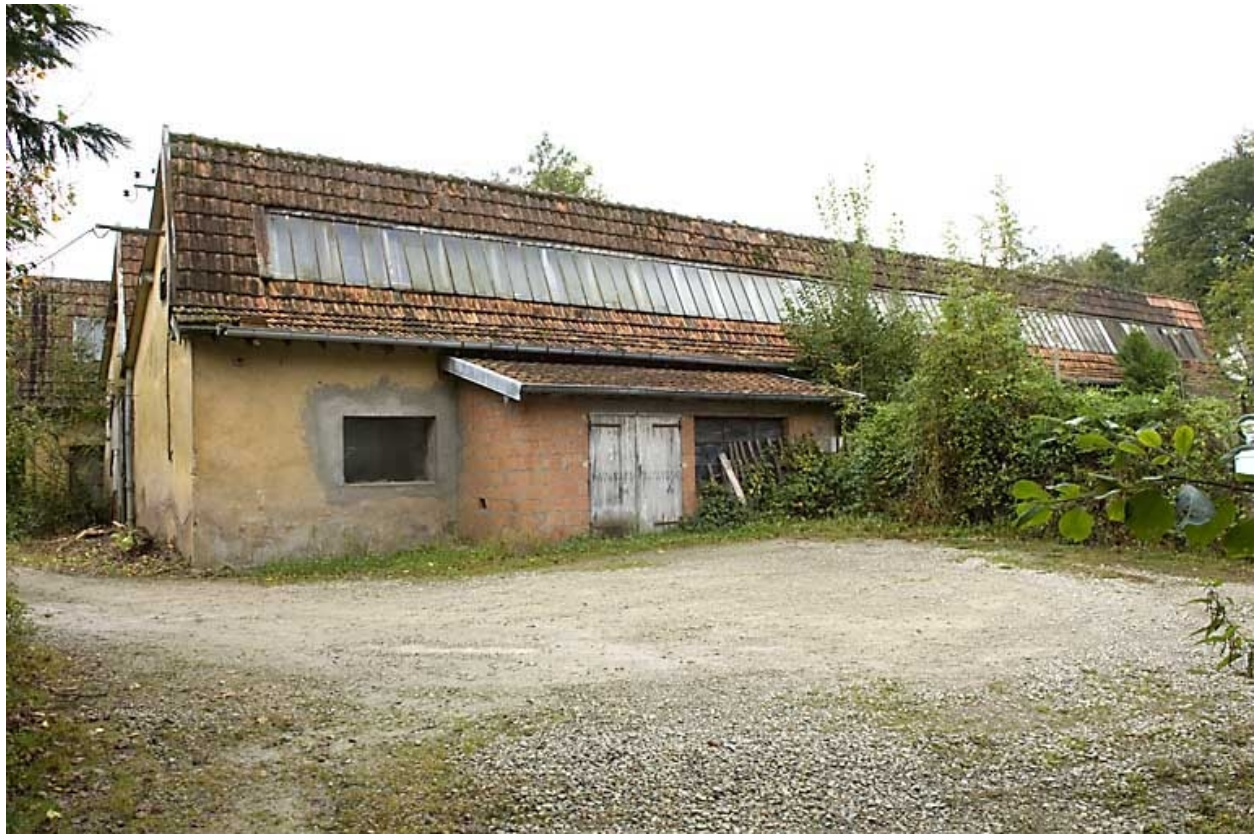
Atelier de fabrication. Vue depuis le nord-est.
