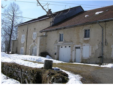
Vue de trois quarts sur l'édifice. Phot. Anne-Laure Madinier IVR43_20083900622NUC1A
