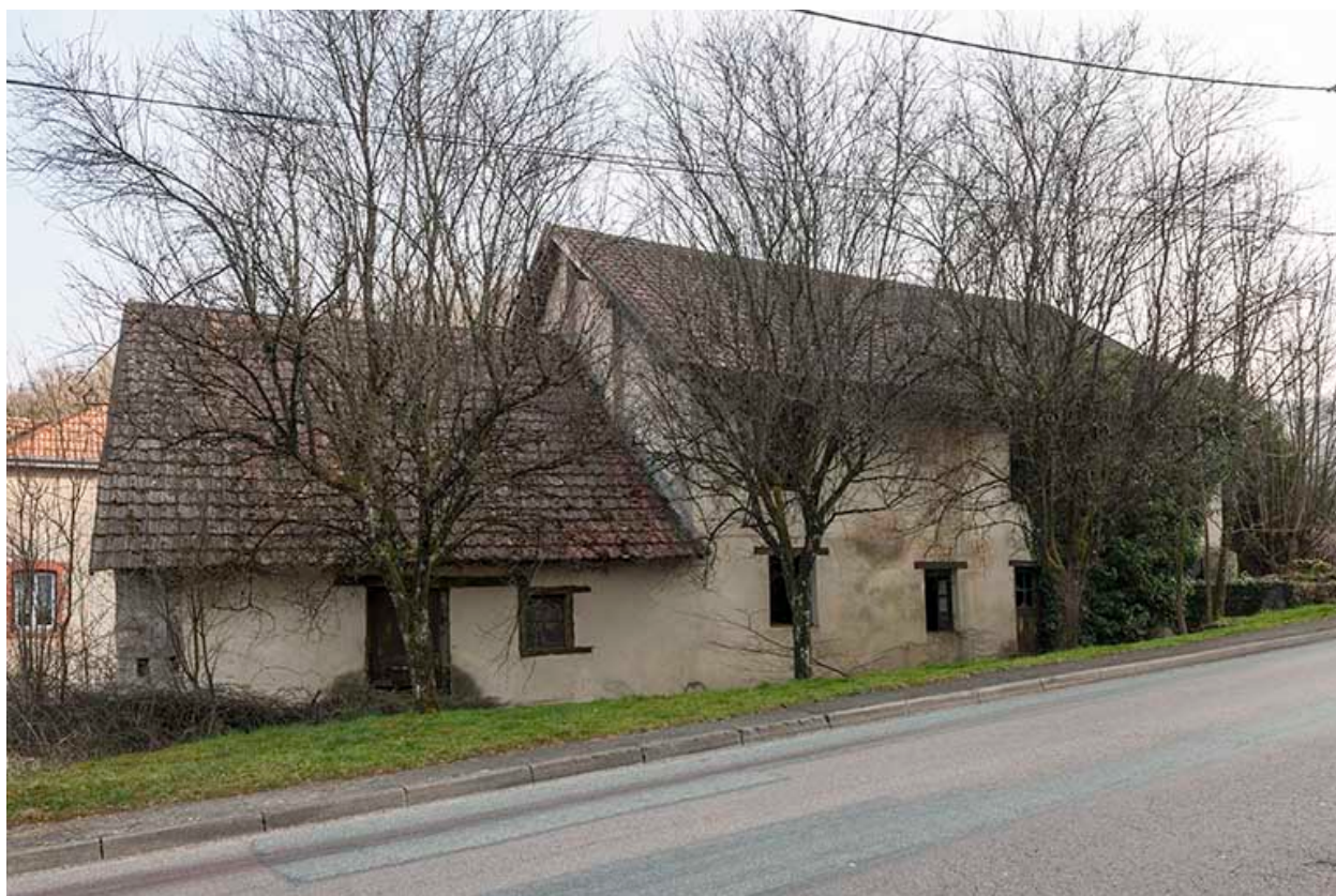
Façade ouest de la minoterie.
