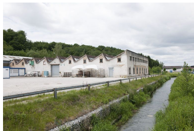
Atelier de menuiserie depuis l'est. Phot. Jérôme Mongreville IVR43_20122501022NUC4A
