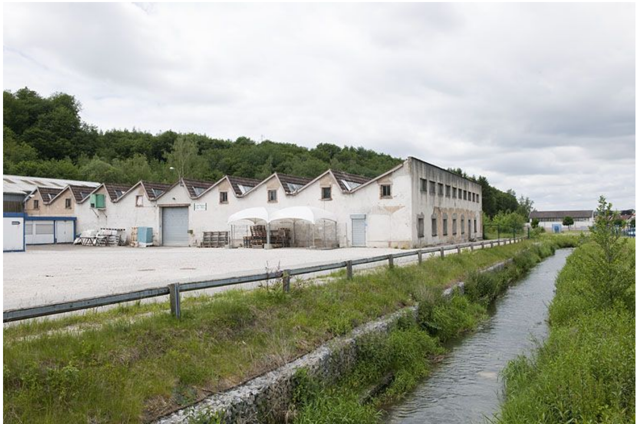
Atelier de menuiserie depuis l'est.
