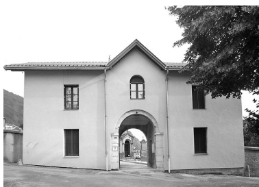
Pavillon d'entrée (conciergerie et logement). Phot. Yves Sancey IVR43_20033901048X
