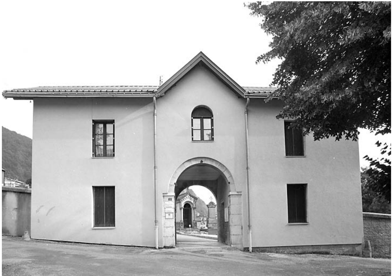
Pavillon d'entrée (conciergerie et logement).
