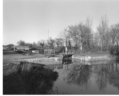
Vue d'ensemble prise de l'amont. Phot. Jean-Luc Duthu IVR26_19925800198X
