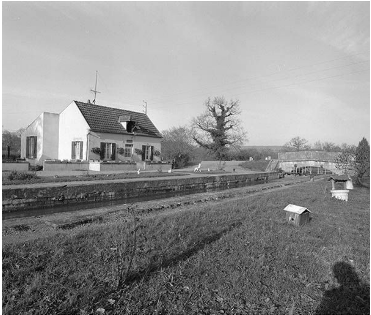
Vue d'ensemble prise de l'amont.
