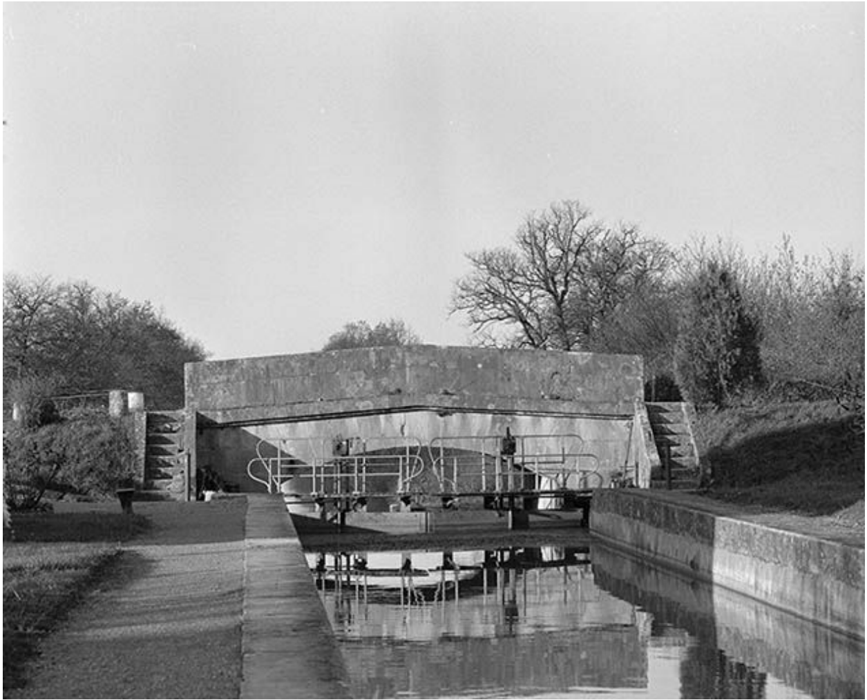
Le pont. Vue prise de l'amont.
