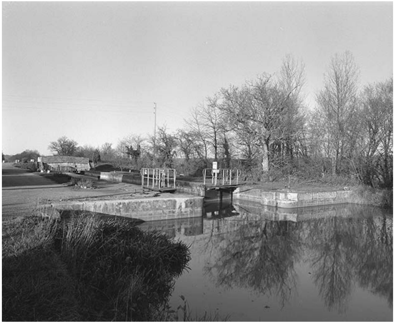
Vue d'ensemble prise de l'amont.
