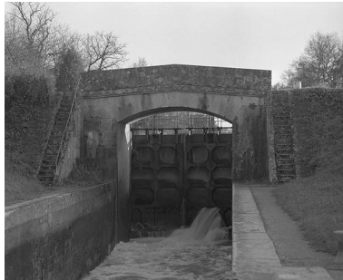
Le pont et le sas. Vue prise de l'aval. Phot. Jean-Luc Duthu IVR26_19925800200X
