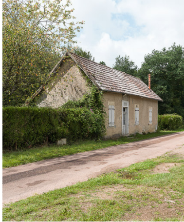
Vue de la maison éclusière. Phot. Pierre-Marie Barbe-Richaud IVR26_20175800293NUC2A
