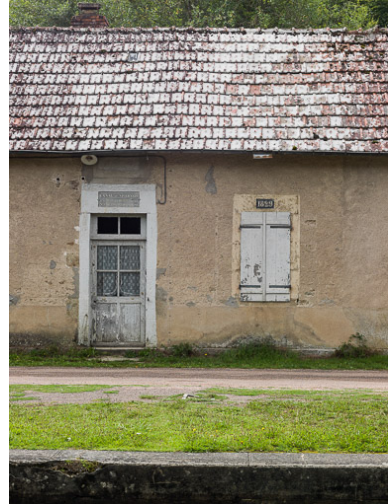
Détail des ouvertures de la maison éclusière. Phot. Pierre-Marie Barbe-Richaud IVR26_20175800294NUC2A
