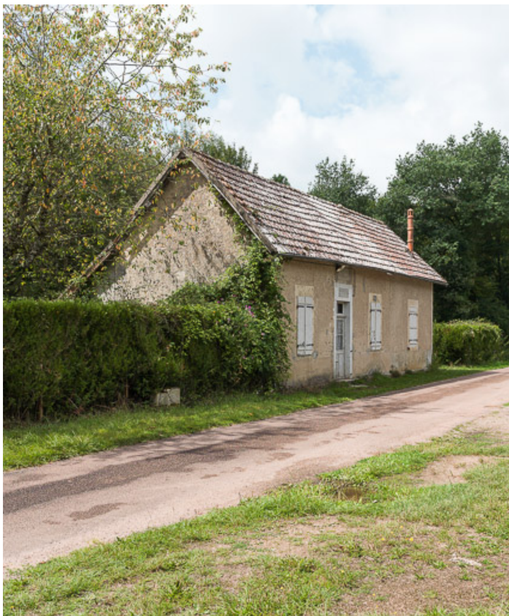
Vue de la maison éclusière.
