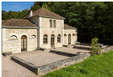
La façade antérieure, exposée au sud-est.
