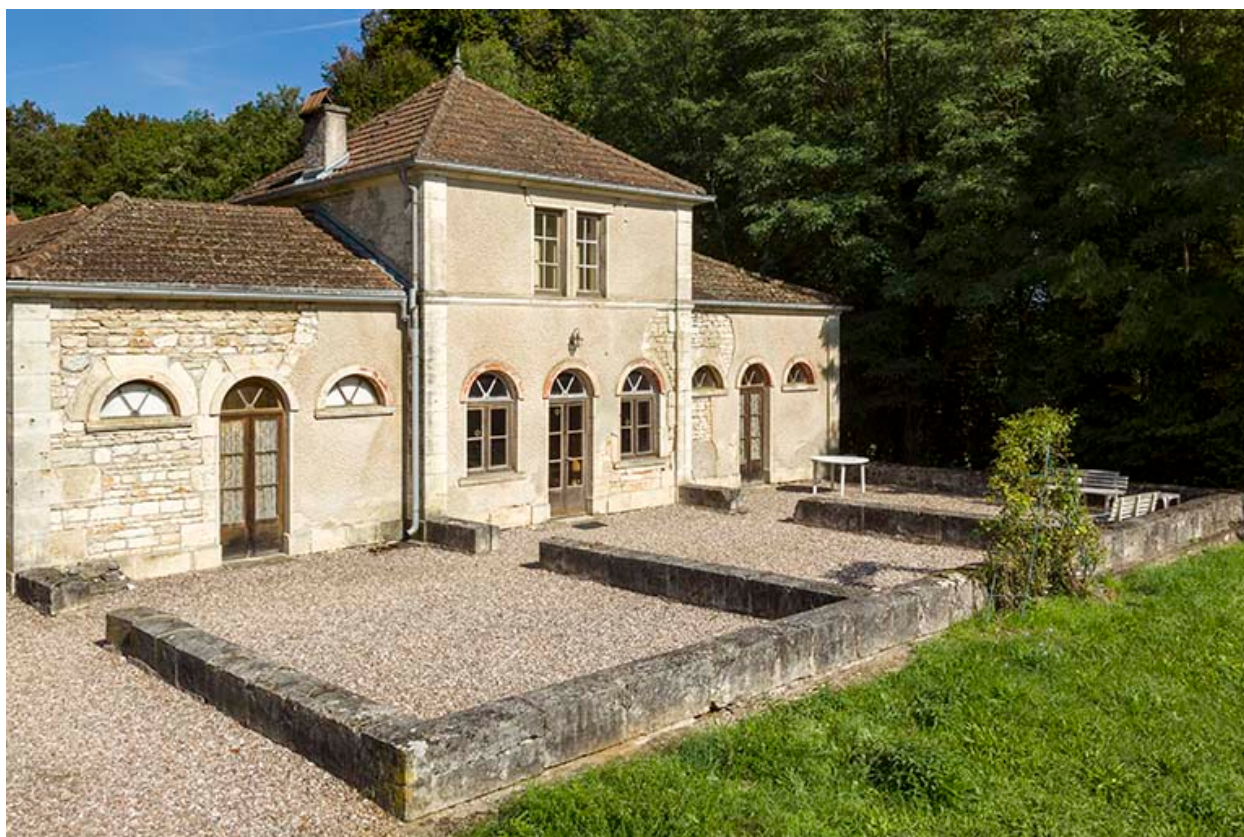
La façade antérieure, exposée au sud-est.
