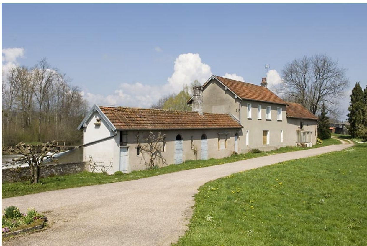
Logement et dépendances depuis le sud.
