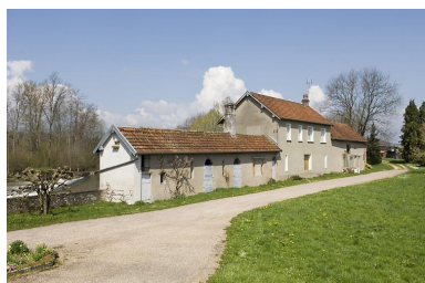
Logement et dépendances depuis le sud. Phot. Jérôme Mongreville IVR43_20087000514NUC2A
