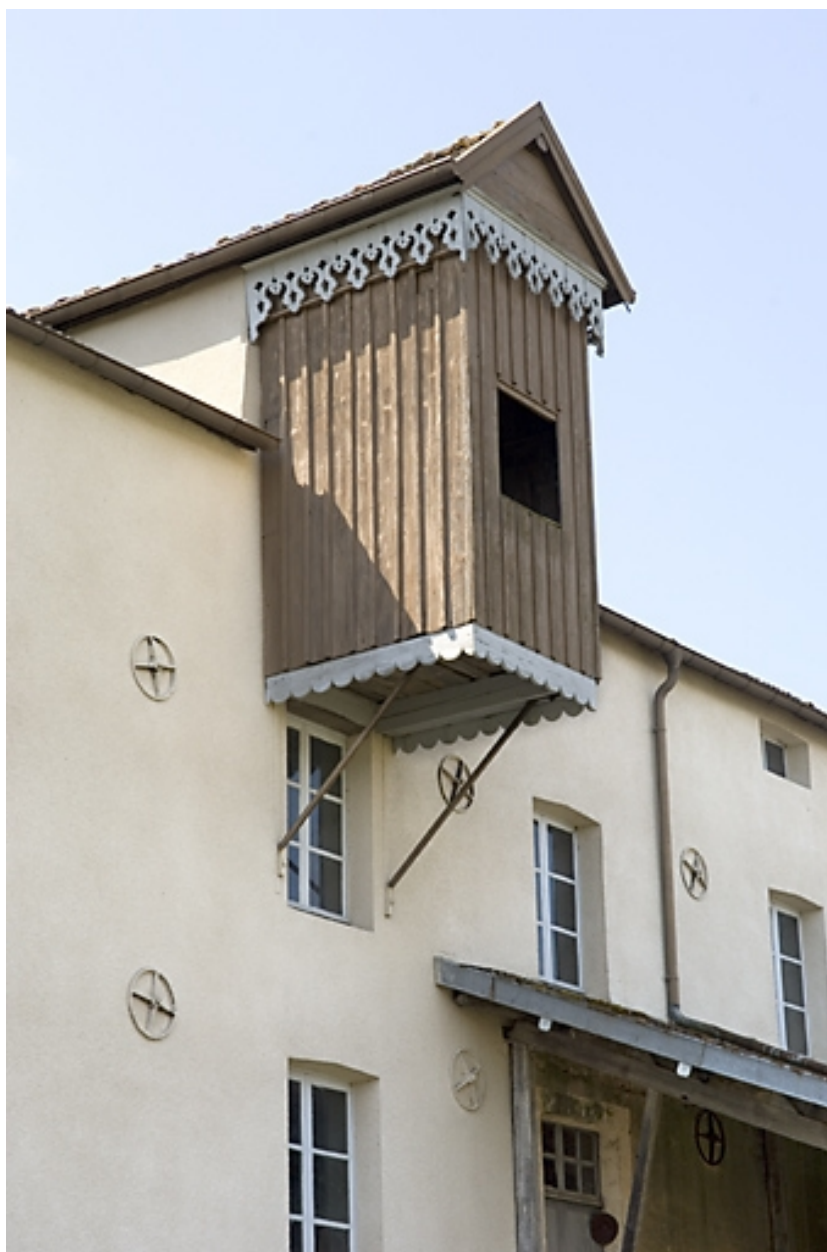
Façade antérieure. Edicule du monte-sac.
