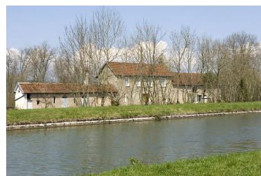
Dépendances et logement depuis l'est. Phot. Jérôme Mongreville IVR43_20087000507NUC2A
