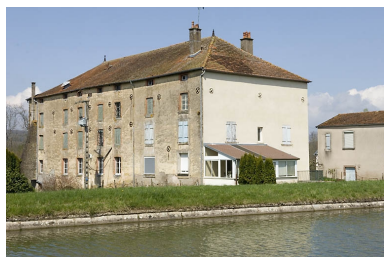
La minoterie vue de trois quarts arrière. Phot. Jérôme Mongreville IVR43_20087000509NUC2A
