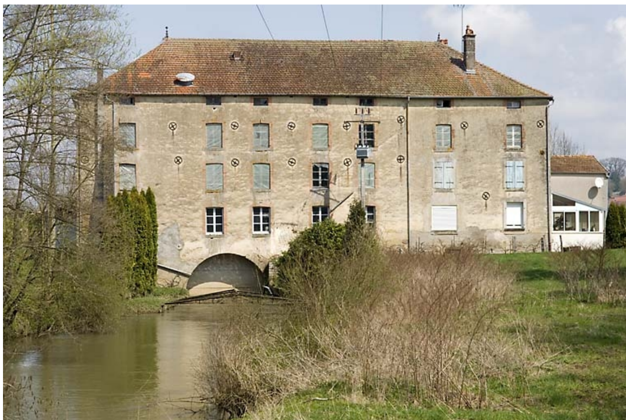
Façade postérieure vue de face.
