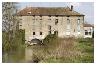
Façade postérieure vue de face. Phot. Jérôme Mongreville IVR43_20087000517NUC2A
