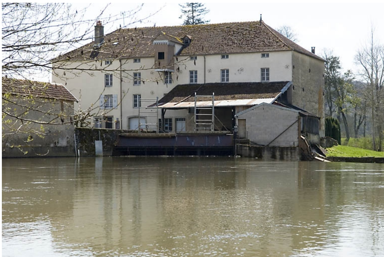
Façade antérieure depuis l'amont.
