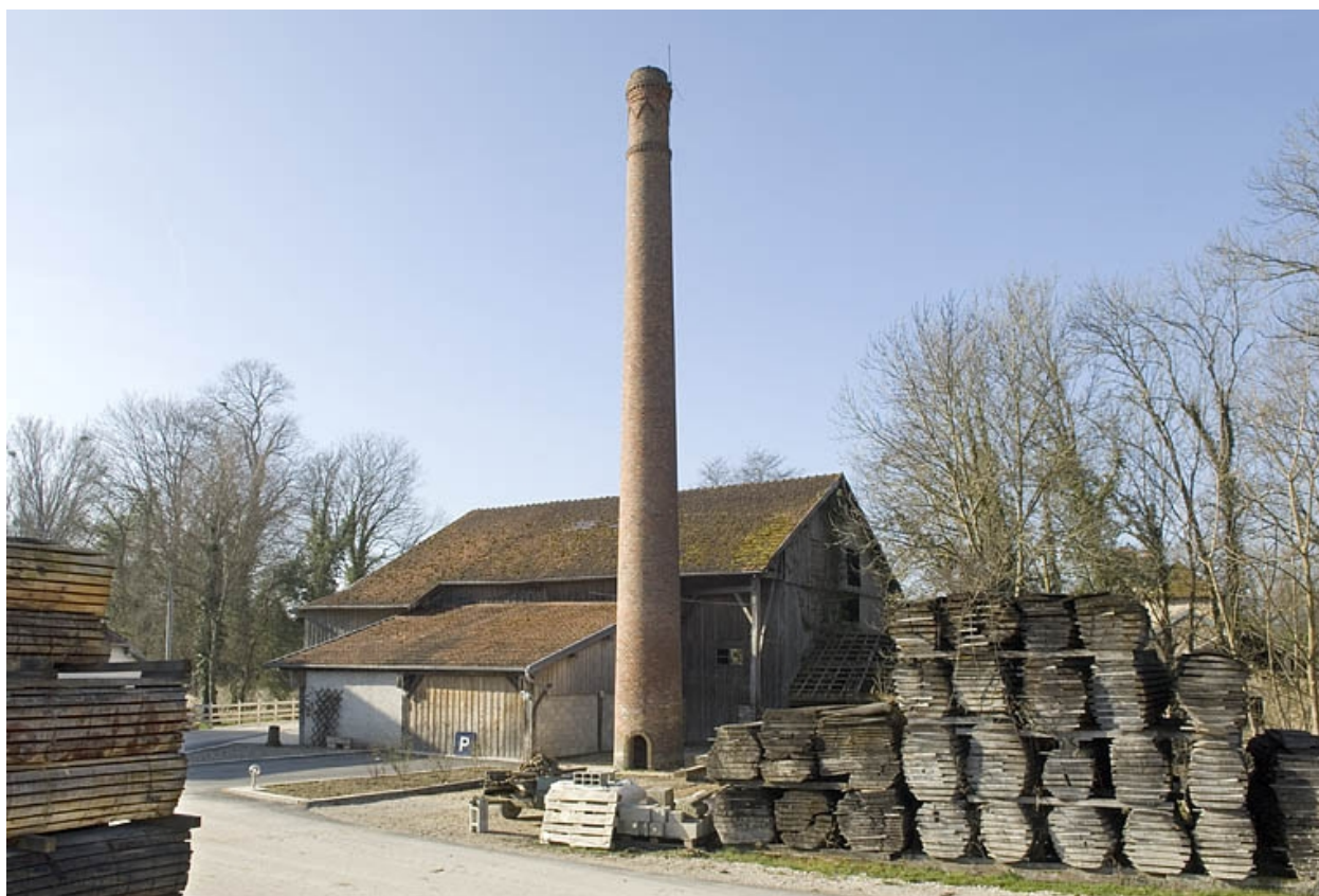
Vue d'ensemble de l'entrée depuis le nord-ouest.
