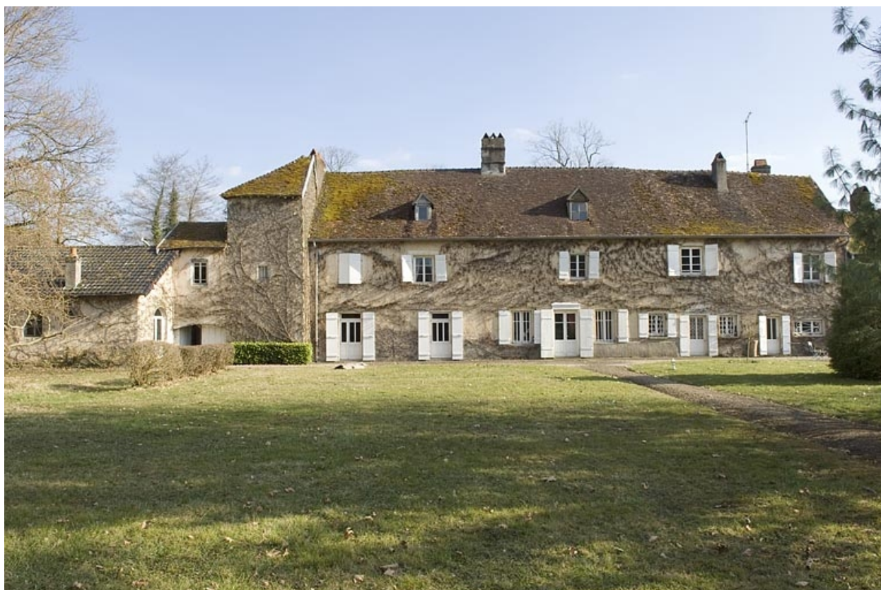
Façade postérieure du logis ouest.
