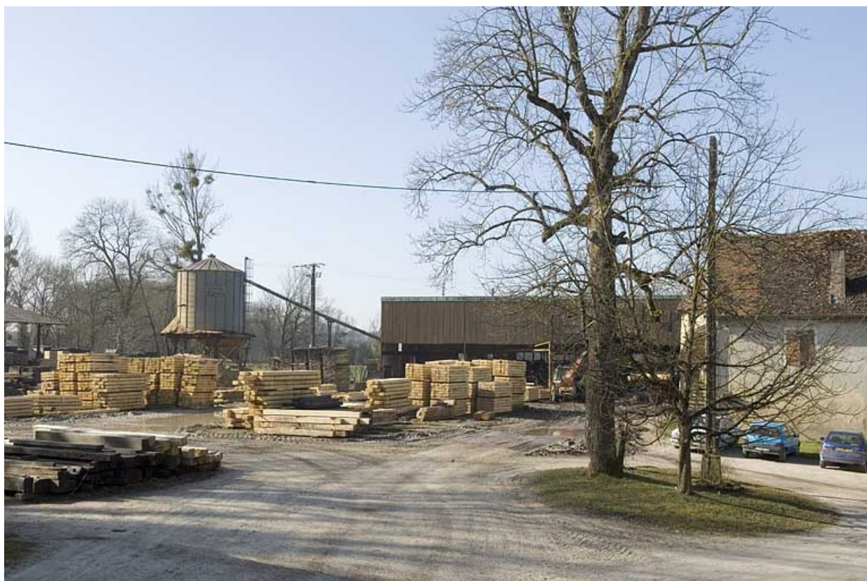
Le chantier de la scierie.
