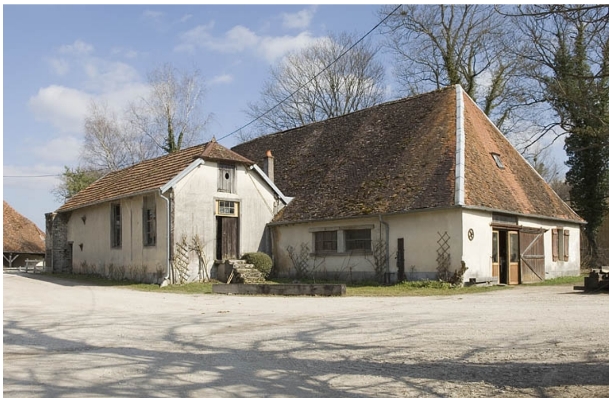
Halle à charbon
