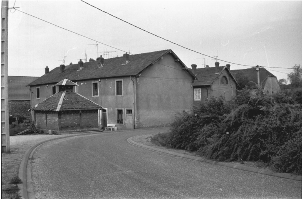
Logement ouvrier à gauche de la rue en 1987: façade postérieure de trois-quarts droit, et lieux d'aisance.
