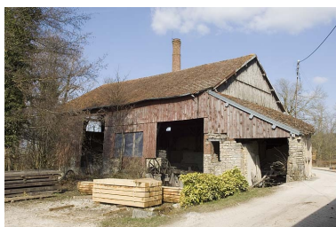
Magasin industriel depuis la cour. Phot. Jérôme Mongreville IVR43_20097000216NUC2A
