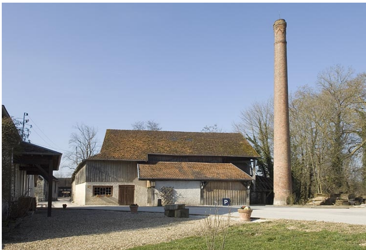
Magasin industriel et cheminée depuis le nord-est.
