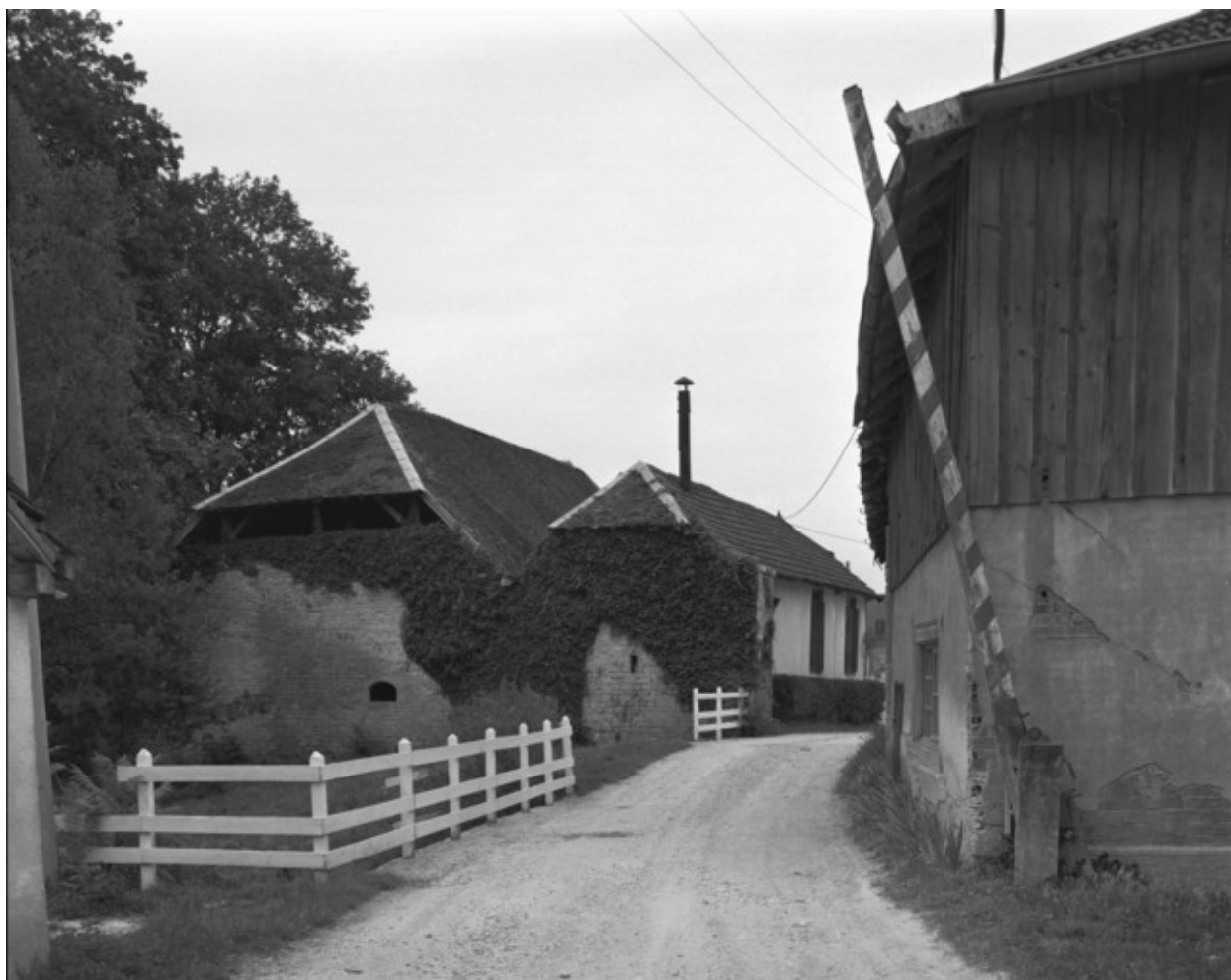
Halle à charbon sud depuis l'entrée en 1989.
