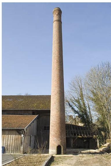
Cheminée depuis le nord. Phot. Jérôme Mongreville IVR43_20097000223NUC2A
