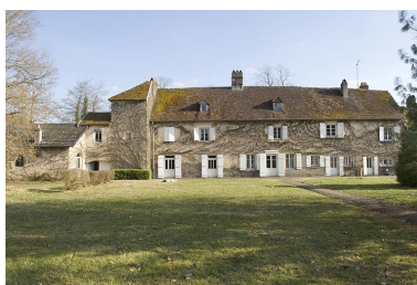
Façade postérieure du logis ouest. Phot. Jérôme Mongreville IVR43_20097000221NUC2A
