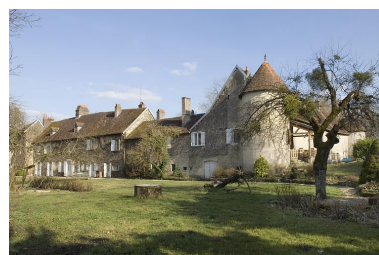
Demeure patronale vue depuis l'ouest. Phot. Jérôme Mongreville IVR43_20097000220NUC2A
