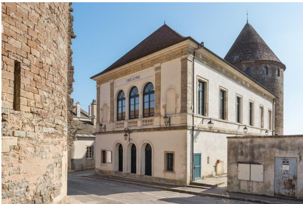
Façades antérieure et latérale droite.
