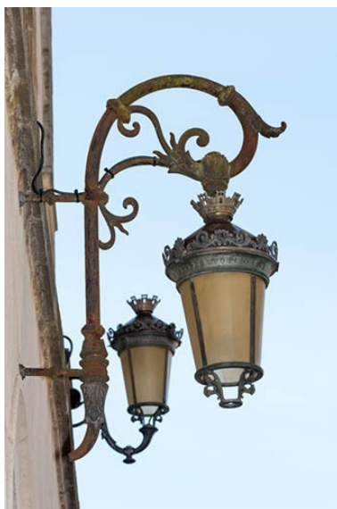
Façade antérieure : lanternes. Phot. Pierre-Marie Barbe-Richaud IVR26_20222100333NUC4A
