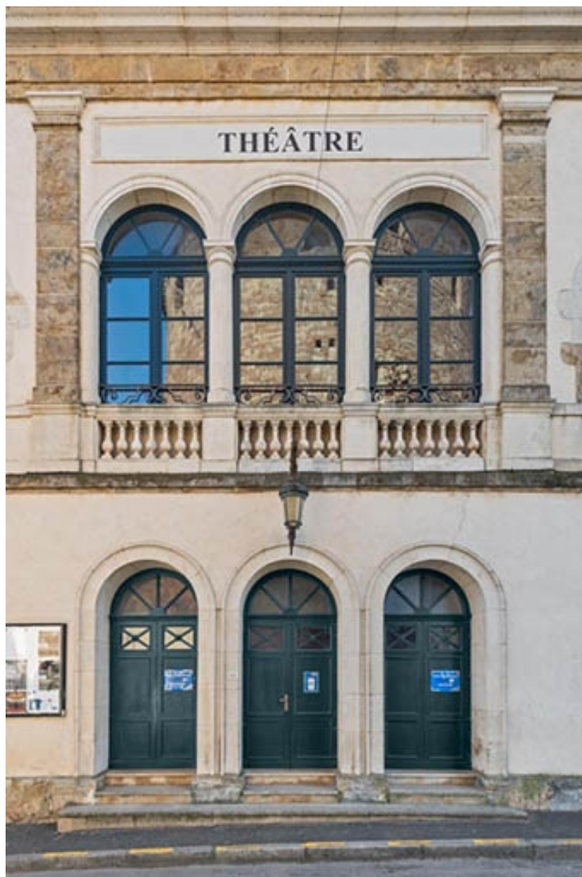
Façade antérieure : travées centrales.
