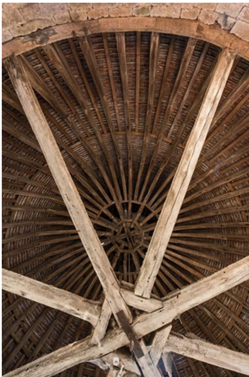
Tour Margot : charpente du 2e étage.
