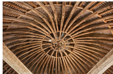
Tour Margot : charpente du 2e étage. Phot. Pierre-Marie Barbe-Richaud IVR26_20222100305NUC4A
