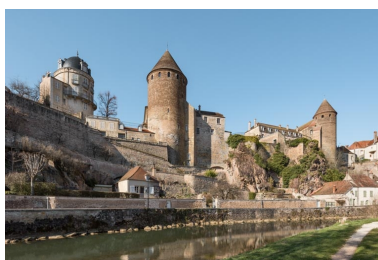
Vue d'ensemble du site, depuis le sud. Phot. Pierre-Marie Barbe-Richaud IVR26_20222100313NUC4A
