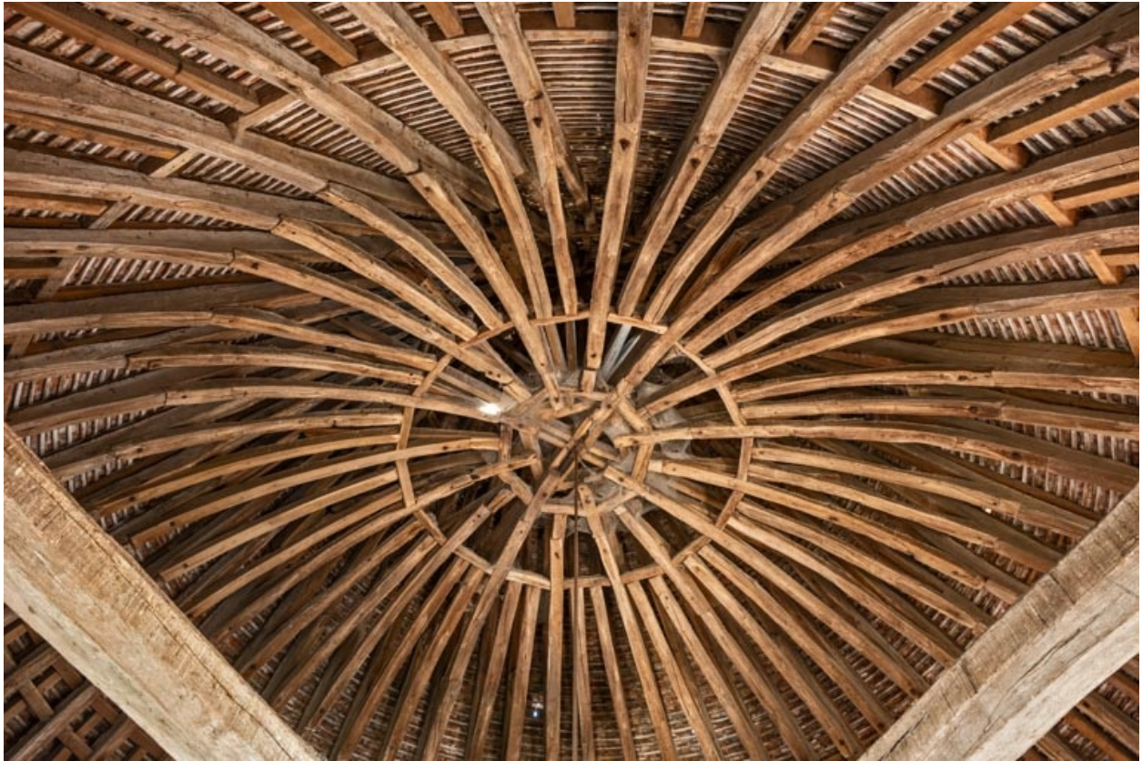
Tour Margot : charpente du 2e étage.
