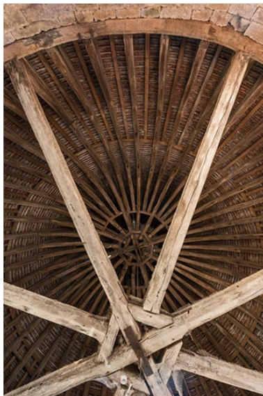
Tour Margot : charpente du 2e étage. Phot. Pierre-Marie Barbe-Richaud IVR26_20222100304NUC4A
