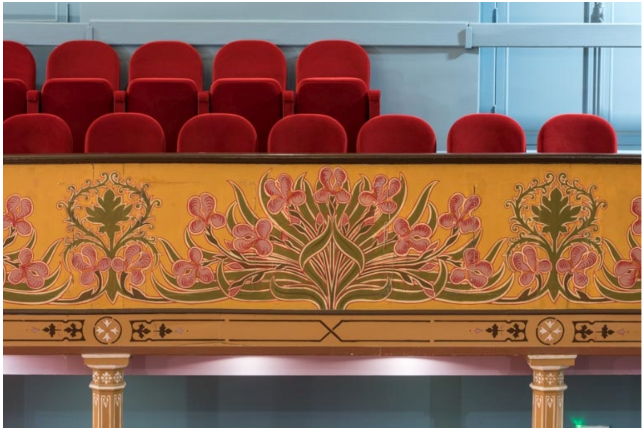
Salle : garde-corps du balcon.
