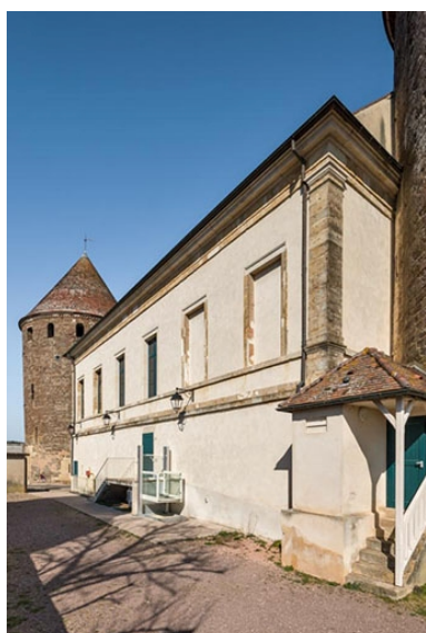
Façade latérale droite. Phot. Pierre-Marie Barbe-Richaud IVR26_20222100311NUC4A
