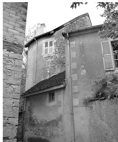
Détail : tourelle dans la maison section AI parcelle 90. Phot. Yves Sancey IVR43_19793900231X
