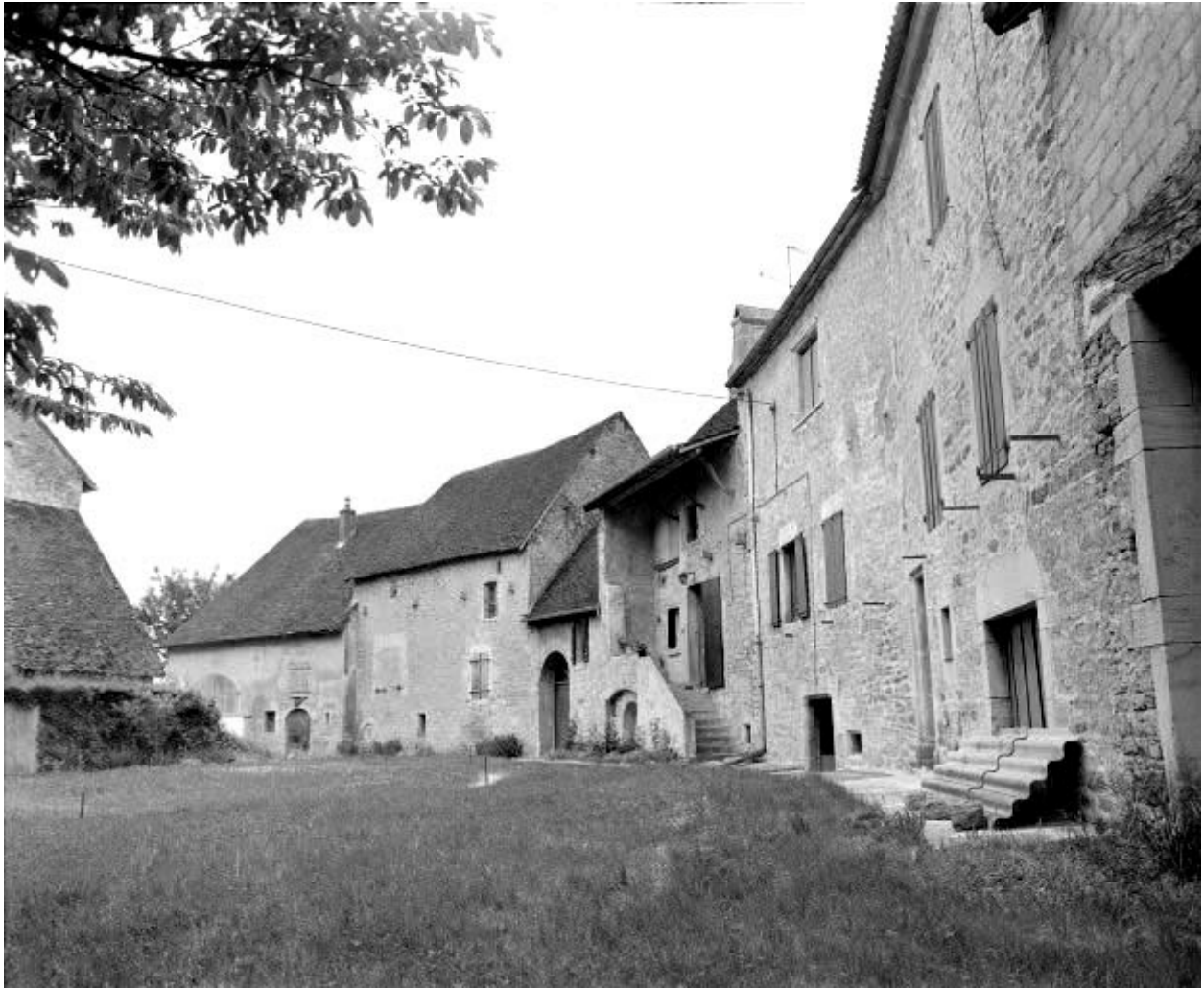
Vue générale depuis l'est.
