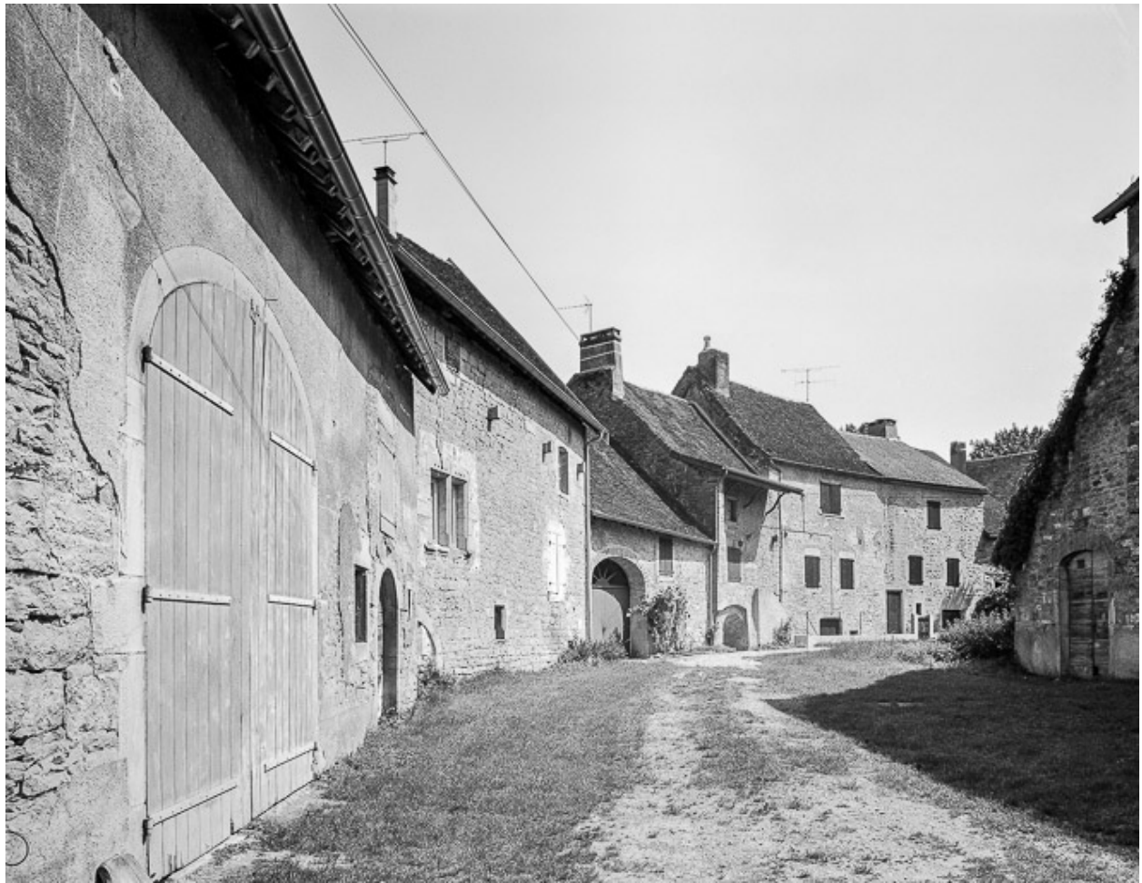
Vue générale depuis l'ouest.
