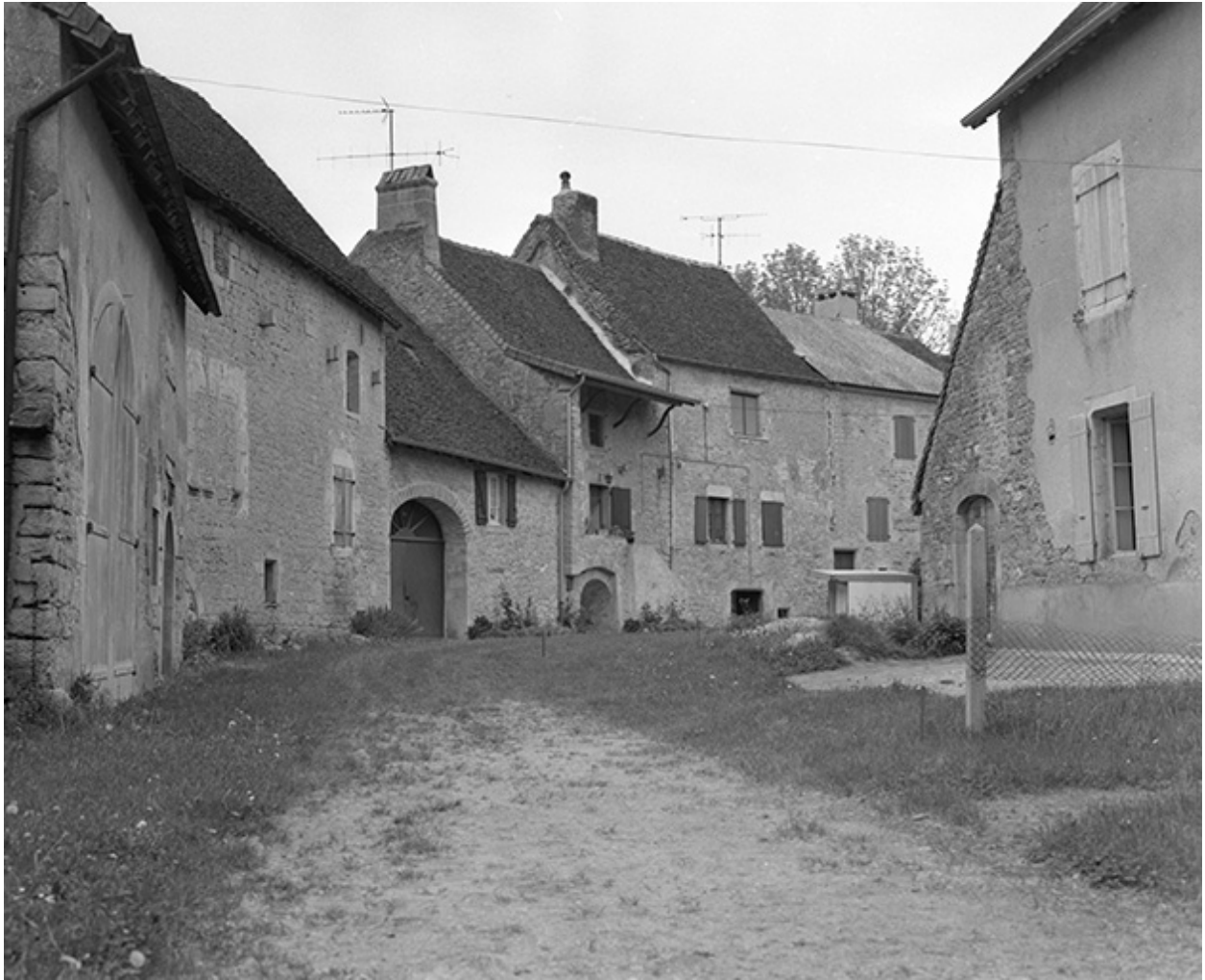
Vue générale depuis l'ouest.
