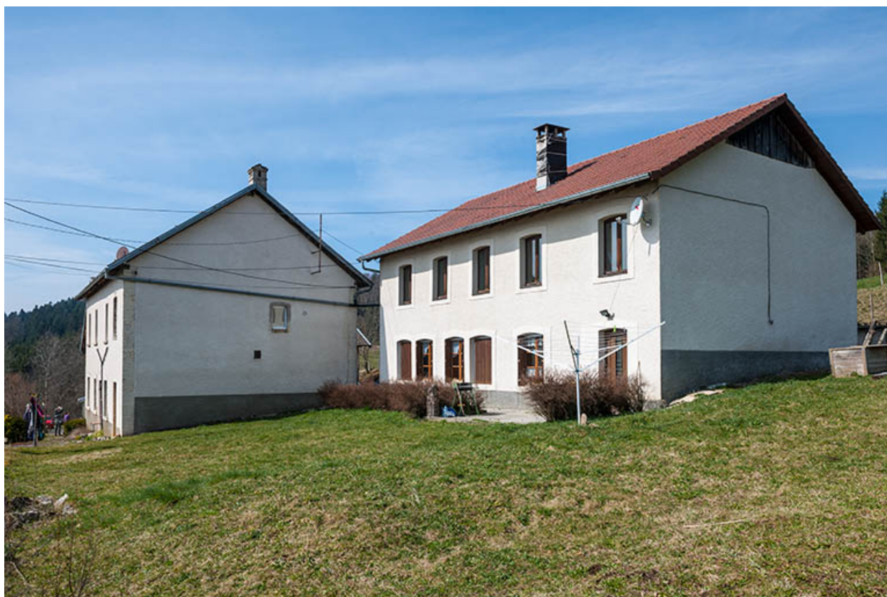
Atelier de fabrication et logement, côté vallée.
