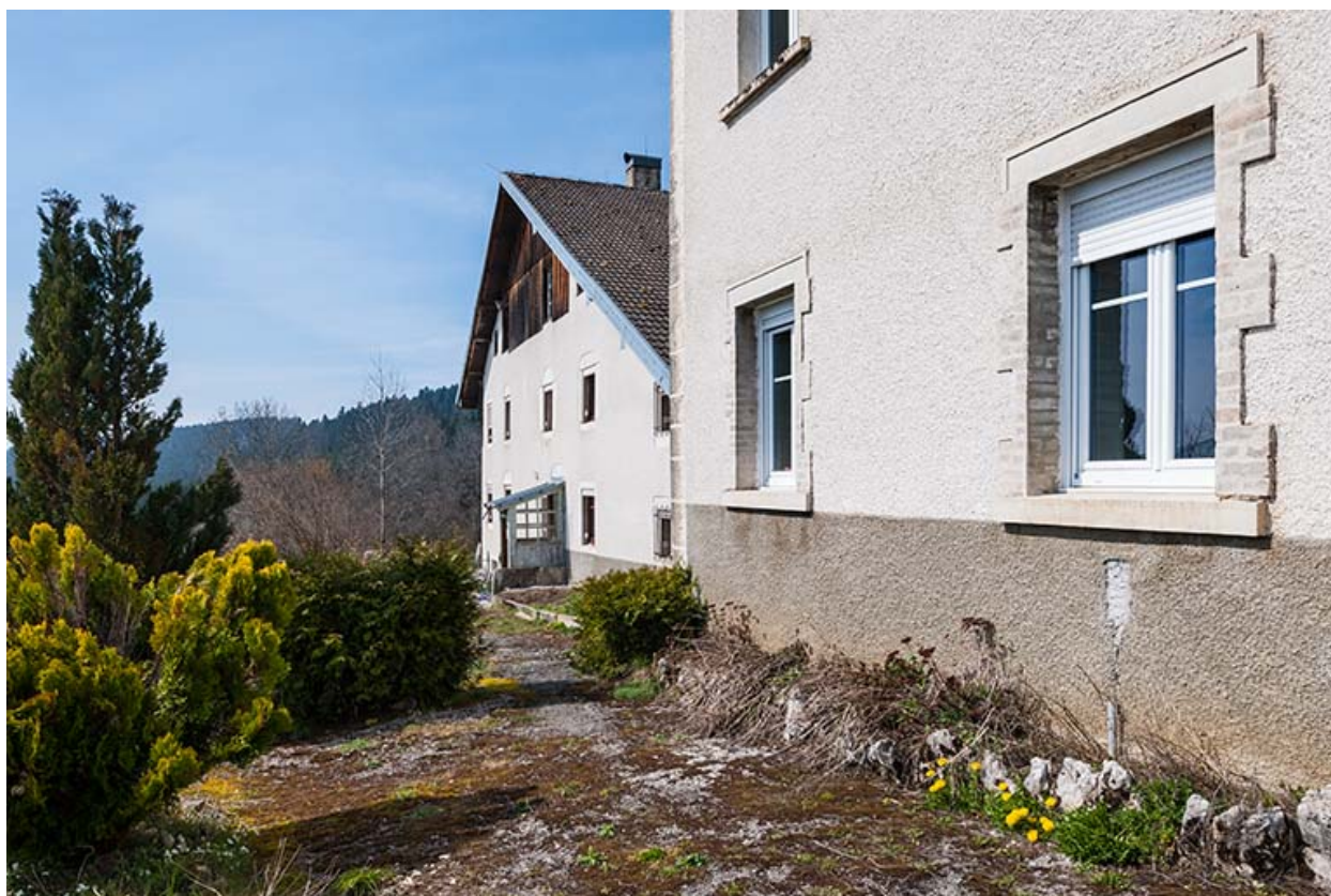
Atelier de fabrication : fenêtres au rez-de-chaussée.
