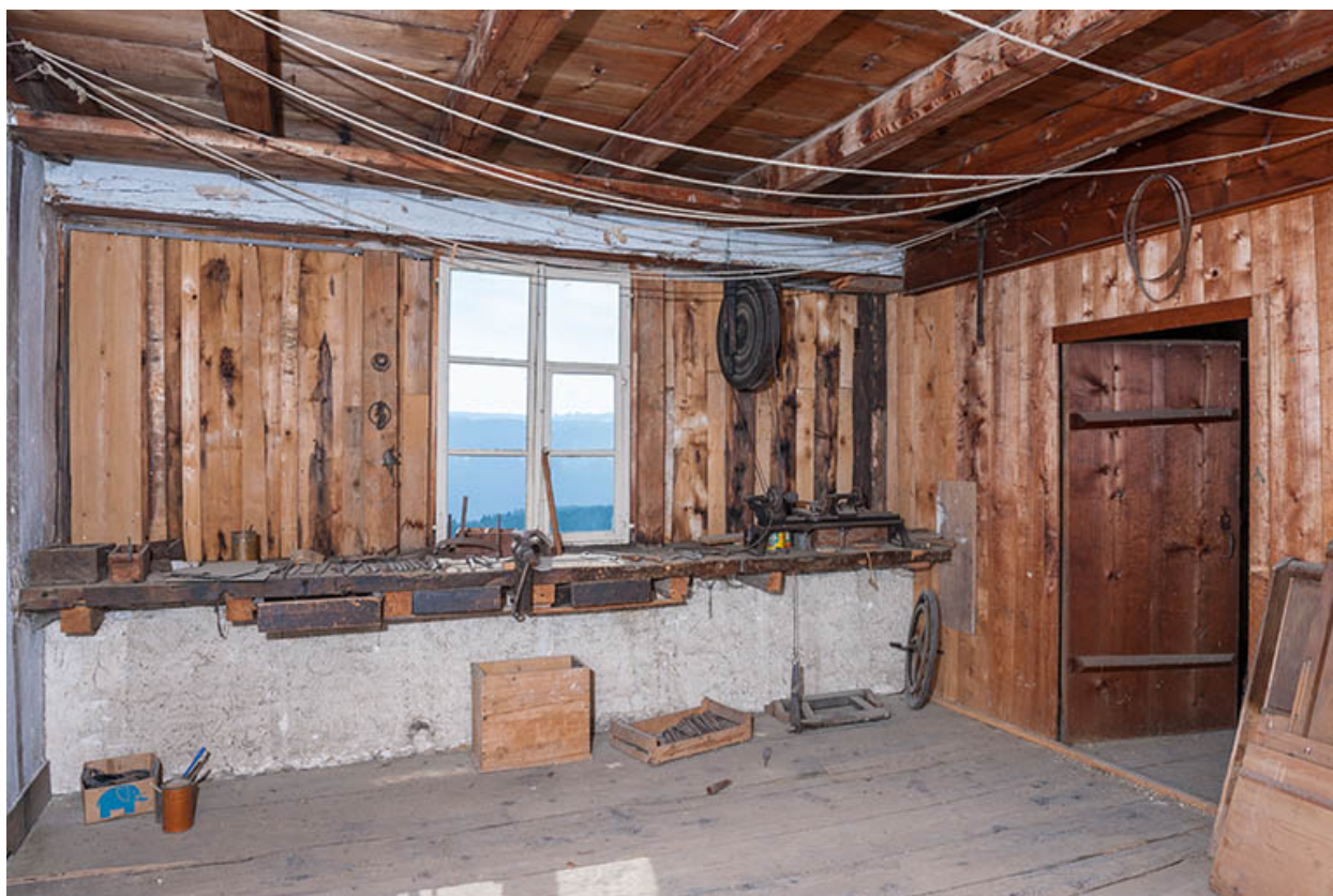
Ferme : atelier à l'étage en surcroît.
