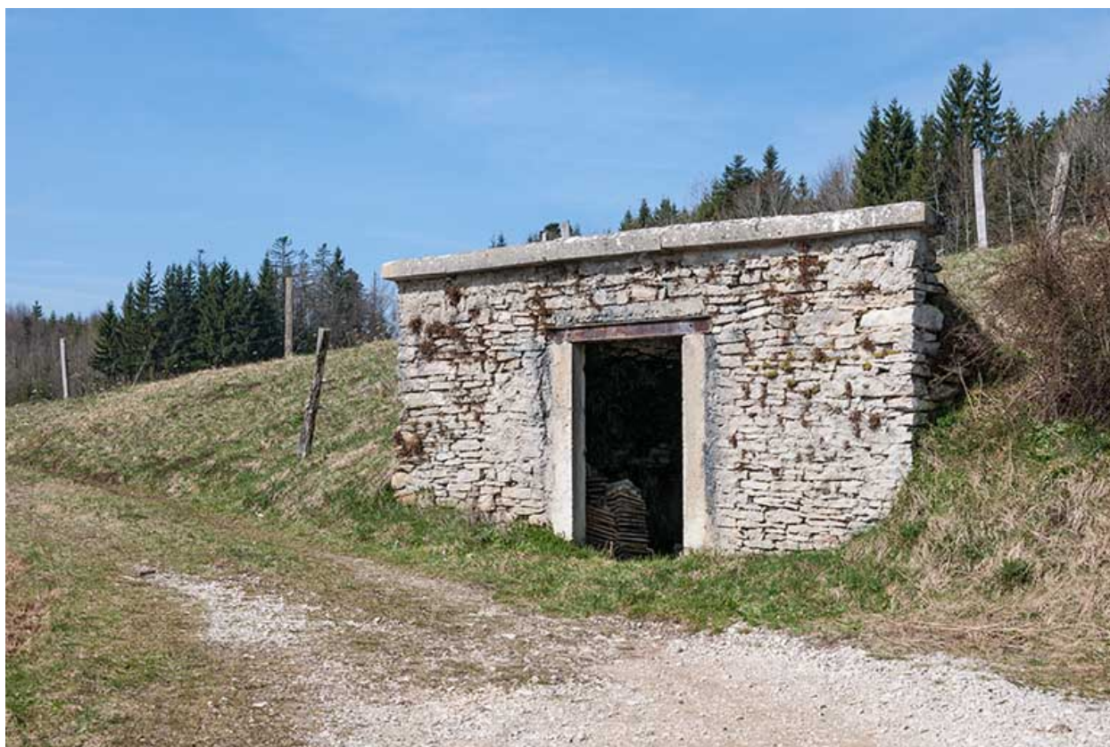
Entrepôt ("cave à pétrole").
