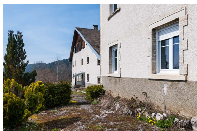
Atelier de fabrication : fenêtres au rez-de-chaussée. Phot. Jérôme Mongreville IVR43_20142500271NUC4A
