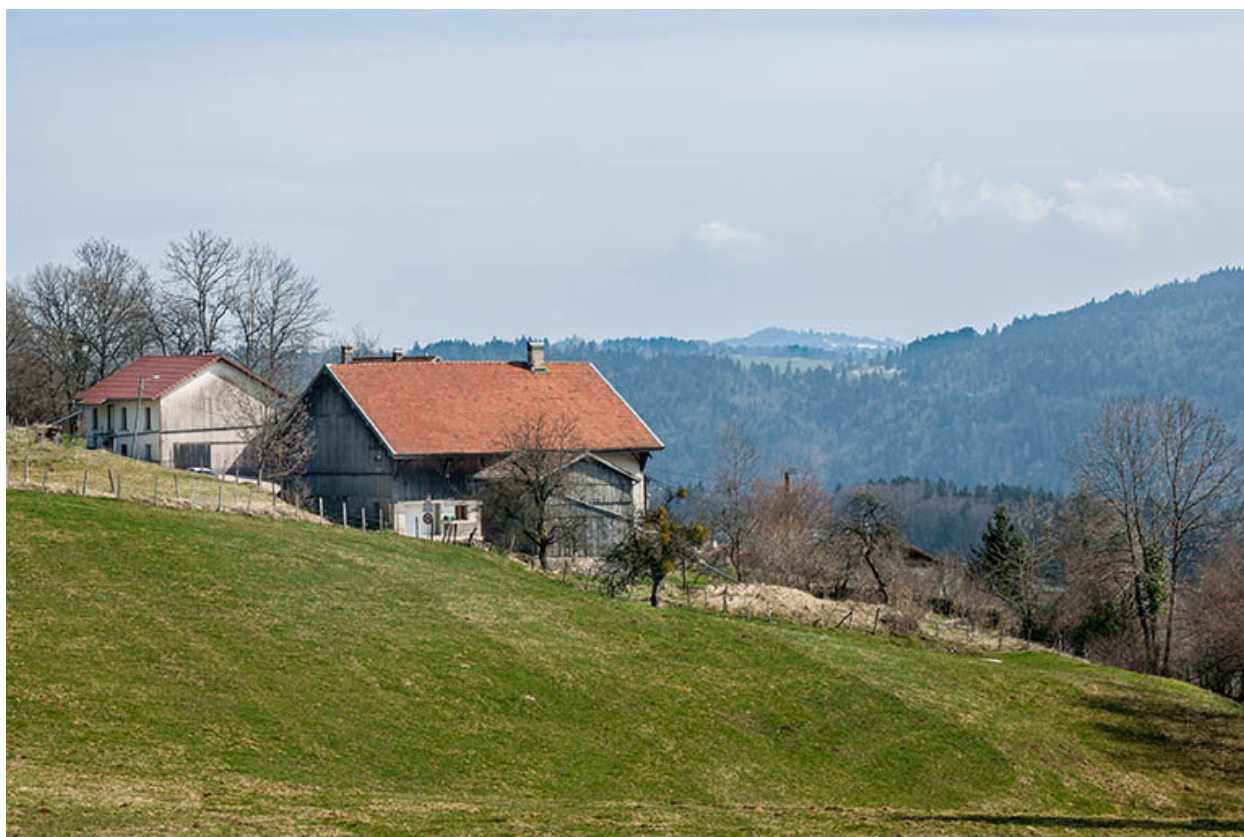
Garage, ferme et logement, depuis l'ouest.
