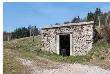
Entrepôt ("cave à pétrole"). Phot. Jérôme Mongreville IVR43_20142500275NUC4A
