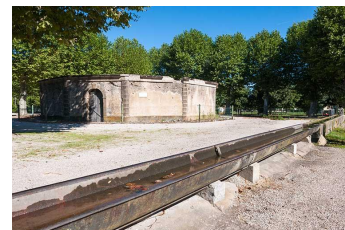
Abreuvoir, place du lavoir.
