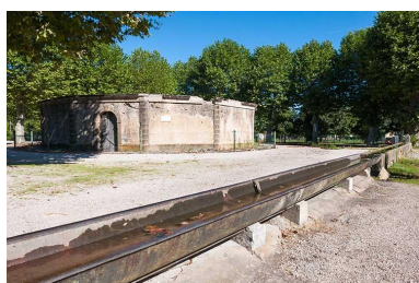
Abreuvoir, place du lavoir. Phot. Jérôme Mongreville IVR43_20137000284NUCA
